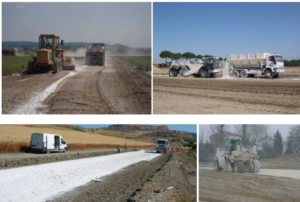
Figura 5. Esecuzione del trattamento a calce in linea
