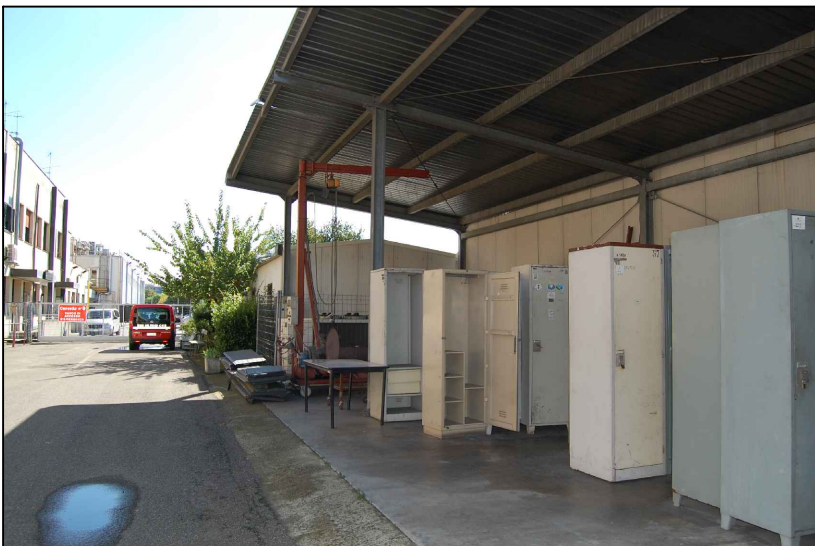
VISTA DELLA CENTRALE TECNOLOGICA
