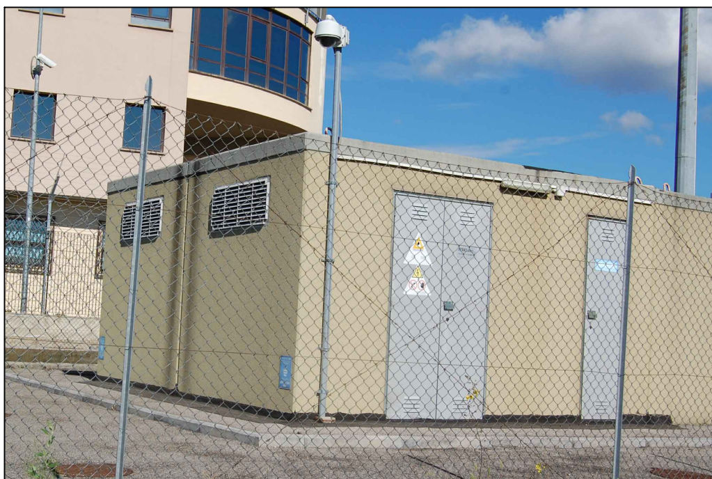
VISTA SUD-EST DELLA CENTRALE TECNOLOGICA
