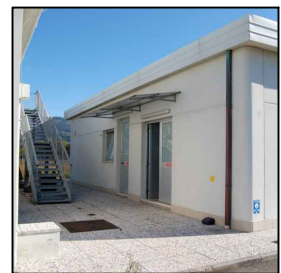
VISTA TRA I DUE EDIFICI
