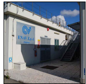
VISTA TRA I DUE EDIFICI
