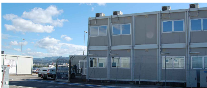
VISTA PROSPETTO OVEST
