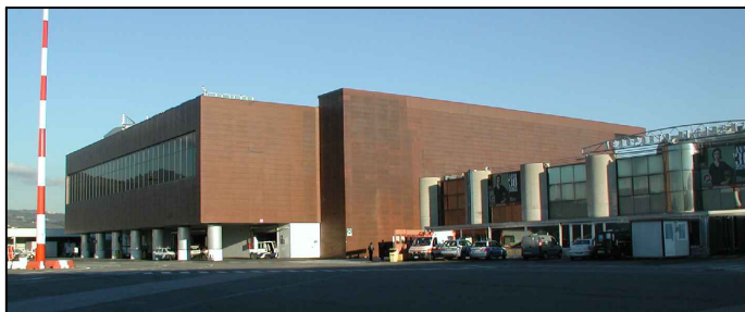
VISTA TERMINAL DA AIRSIDE
