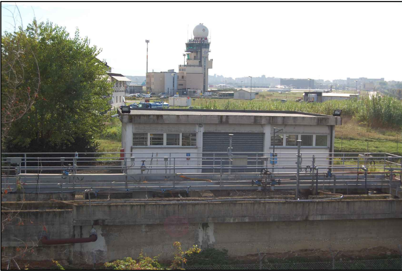
VISTA DEPURATORE VERSO LA TWR
