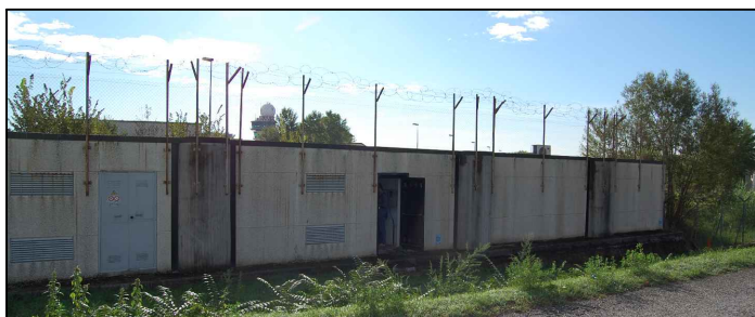
VISTA DELLA CENTRALE TECNOLOGICA
