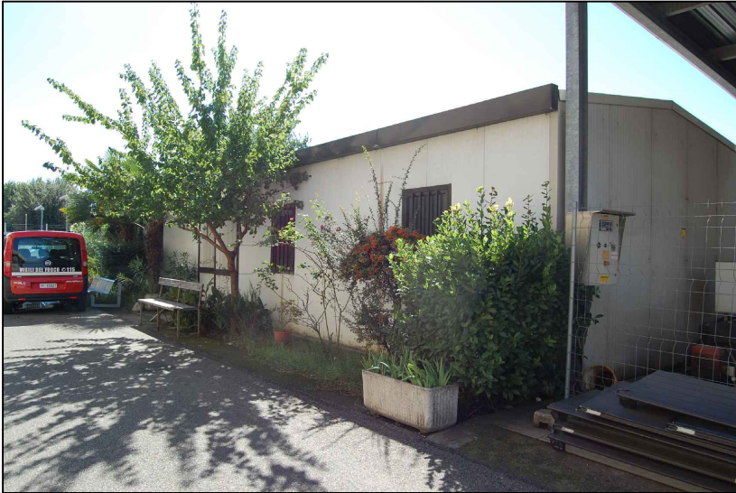
VISTA DELLA CENTRALE TECNOLOGICA
