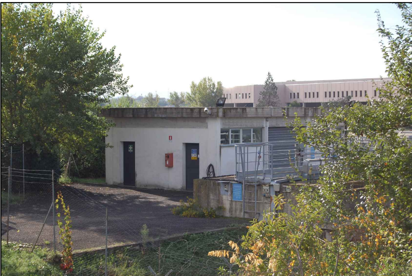
VISTA NORD OVEST DEPURATORE
