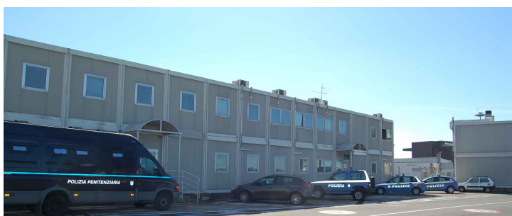
VISTA PROSPETTO OVEST
