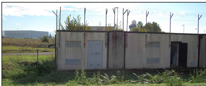
VISTA DELLA CENTRALE TECNOLOGICA
