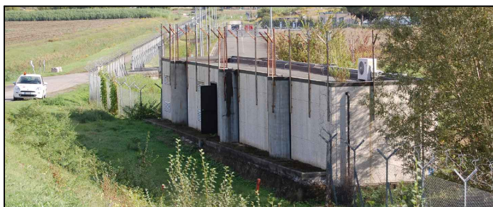
VISTA DELLA CENTRALE TECNOLOGICA
