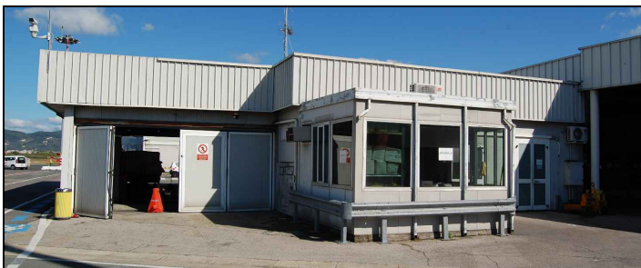
VISTA VERSO IL DEPOSITO
