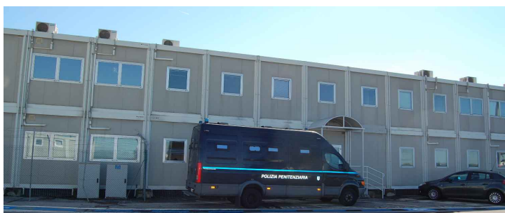
VISTA PROSPETTO OVEST
