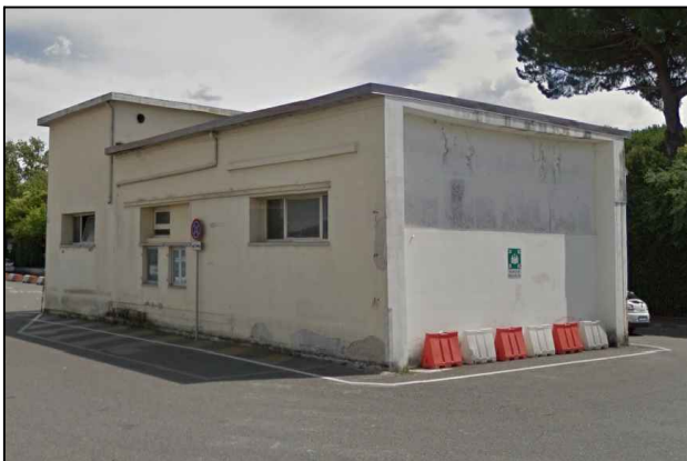
VISTA DELLA CENTRALE TECNOLOGICA
