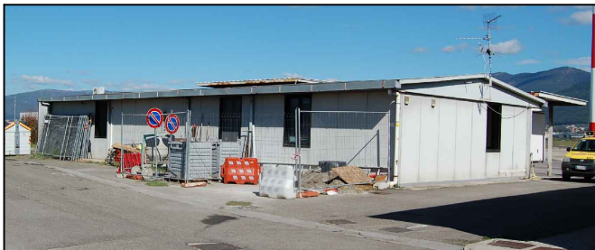
PROSPETTO SUD, MAGAZZINI
