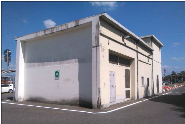
VISTA DELLA CENTRALE TECNOLOGICA
