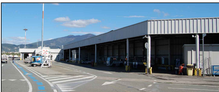
PENSILINA DI RICOVERO MEZZI DI RAMPA
