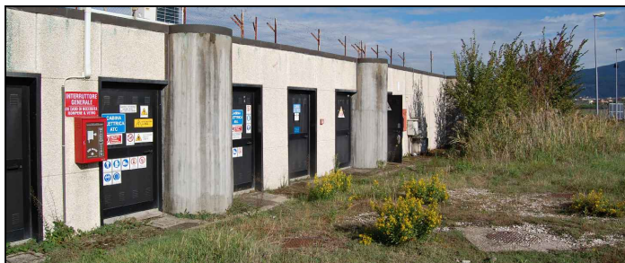
VISTA DELLA CENTRALE TECNOLOGICA
