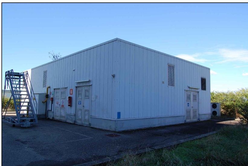
VISTA DELLA CENTRALE TECNOLOGICA
