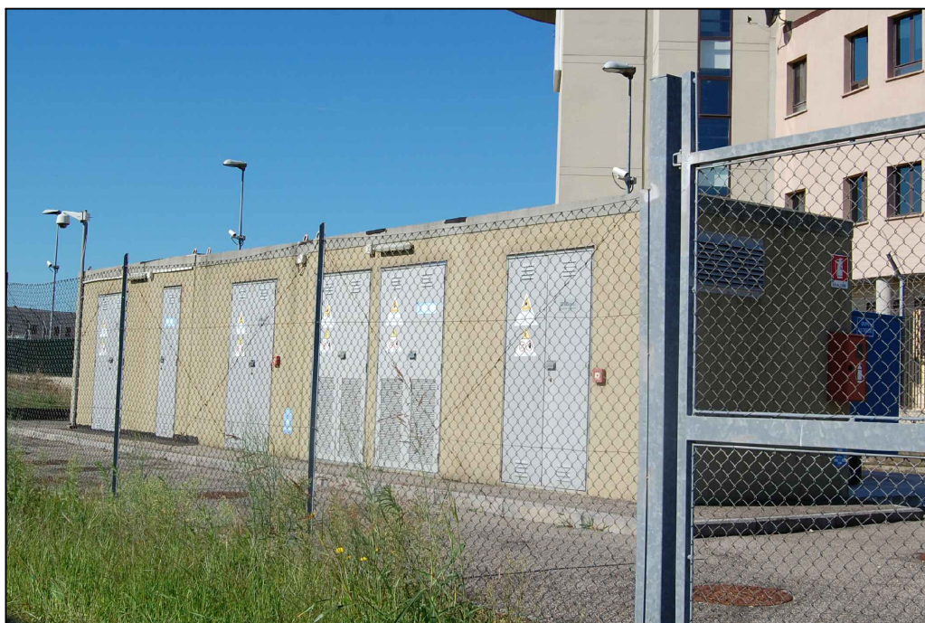
VISTA NORD-EST DELLA CENTRALE TECNOLOGICA
