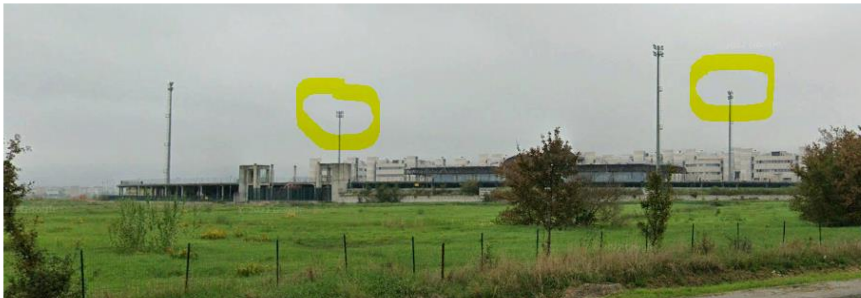
Figura 29 – Superficie di transizione RWY 29 penetrata da torri faro impianto sportivo
