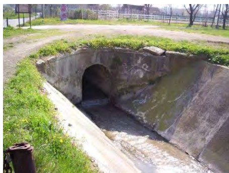
Figura 4-4 – Attraversamento Via delle Due Case
