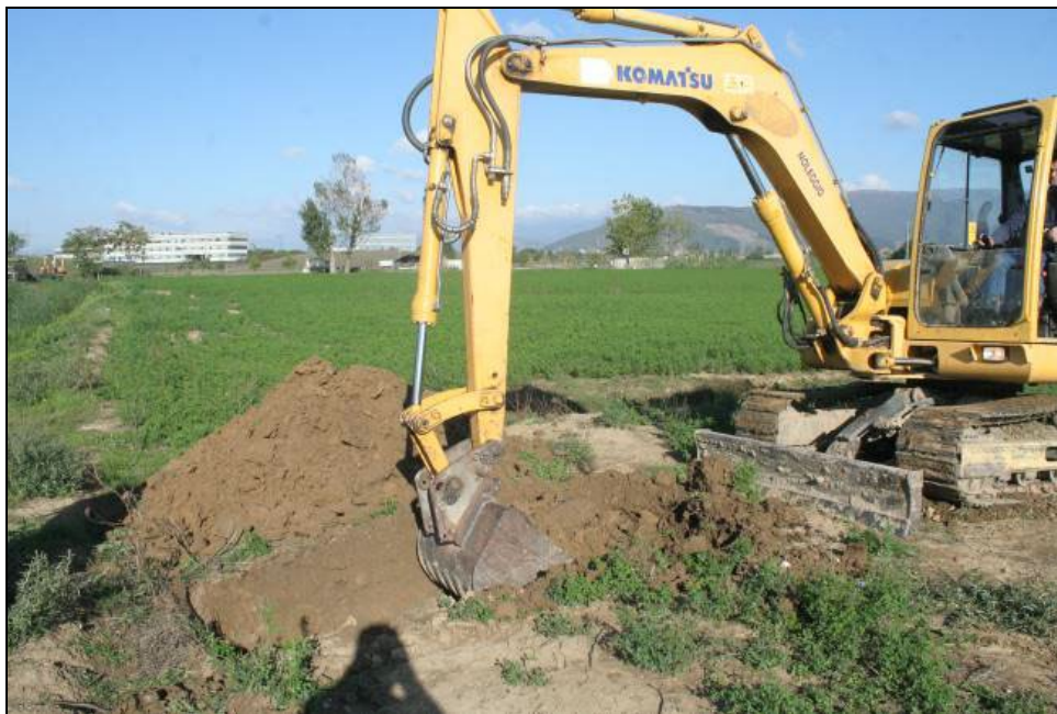
Le operazioni di scavo di un pozzetto geognostico
