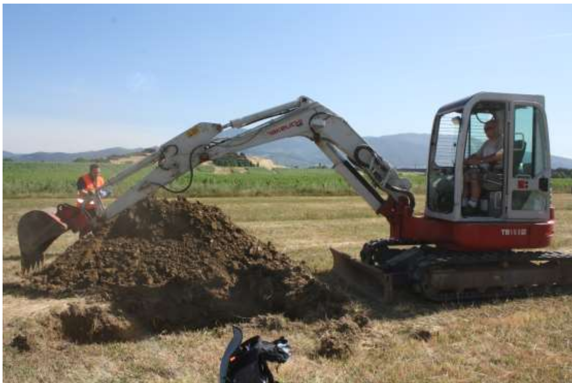
Figura 6 - Pozzetti geognostici in corso d'opera
