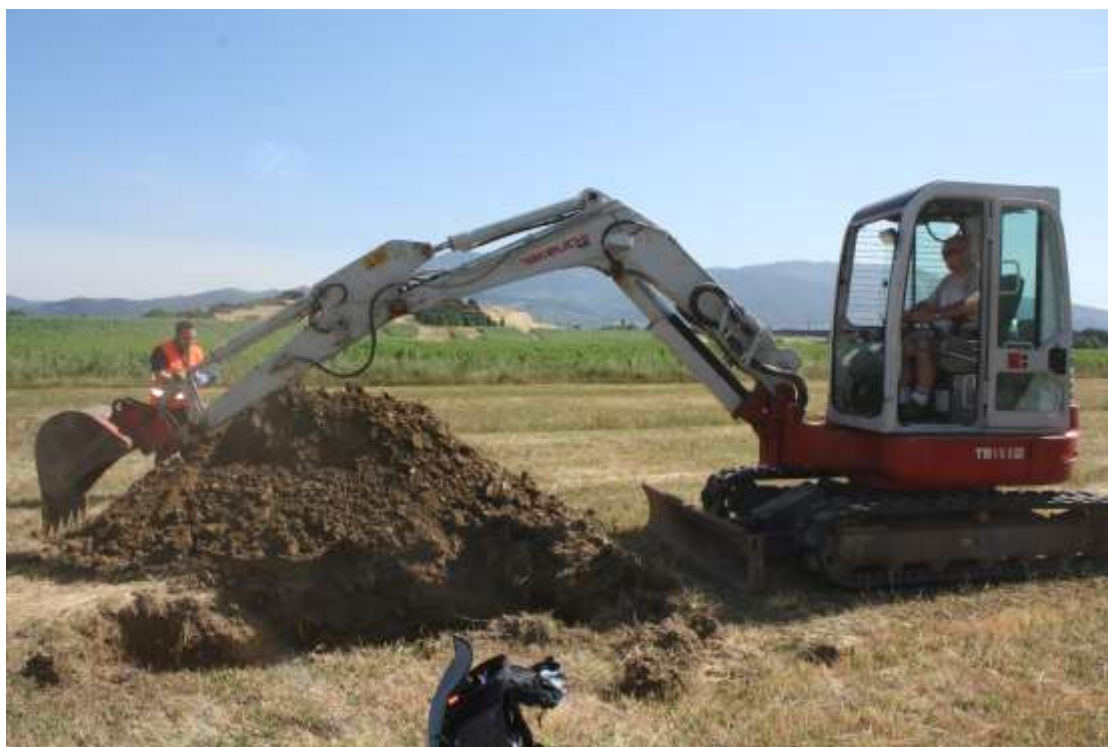
Figura 12 - Pozzetti geognostici in corso d'opera
