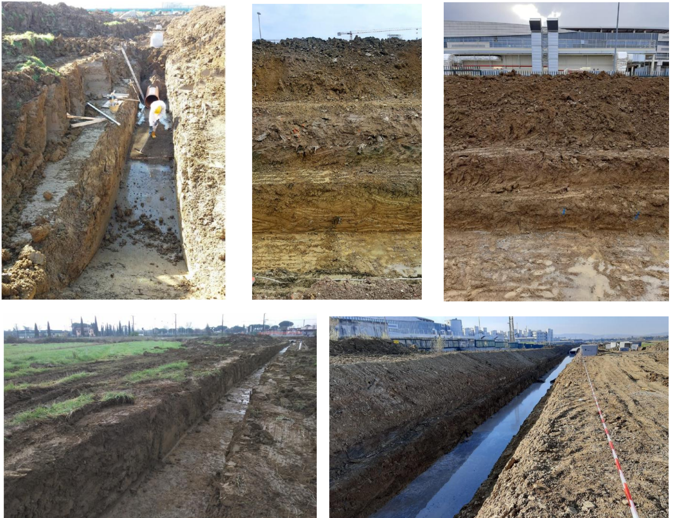
Fig. 17. – Assistenza archeologica durante i lavori di urbanizzazione per il PUE Castello, documentazione fotografica
