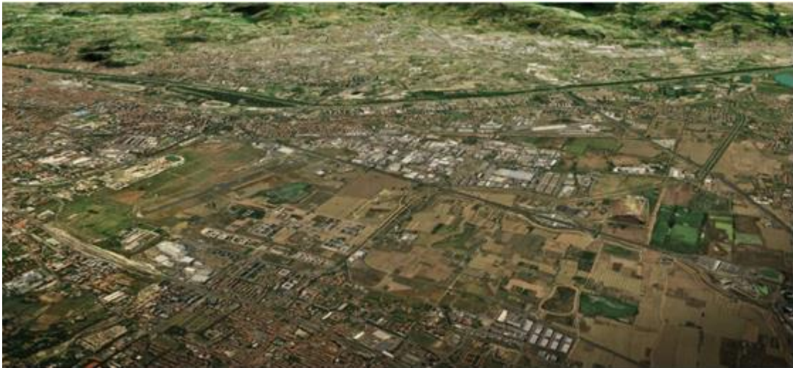
Vista del futuro sedime aeroportuale in direzione sud-est
