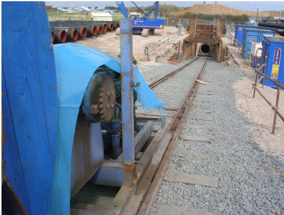
**Figura 25: Foto di un collegamento tra argano e cavo di tiro realizzato nel punto di ingresso del microtunnel.**
