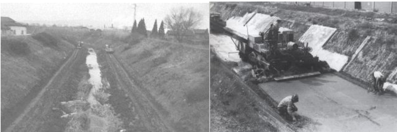
Figura 3-2. Lavori di ampliamento del Fosso Reale (a sinistra) e adeguamento della sezione idraulica del Canale Nuovo Garille alla fine degli anni Settanta (a destra)
