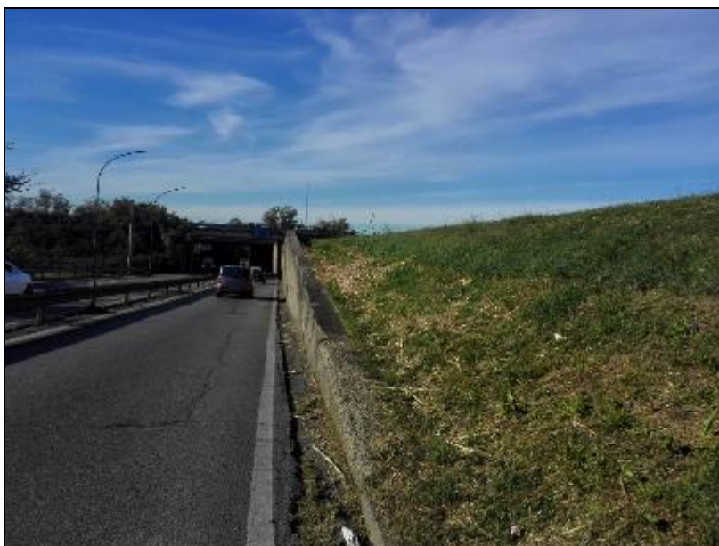
Figura 6-7 Vista del muro di sostegno e del rilevato arginale esistente in adiacenza a via del Cantone
