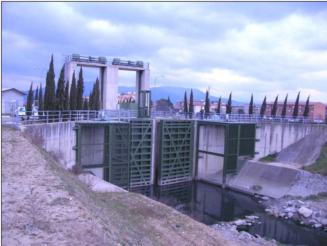
Figura 4.1 – Opera di sbocco del Fosso Reale nel fiume Bisenzio.
