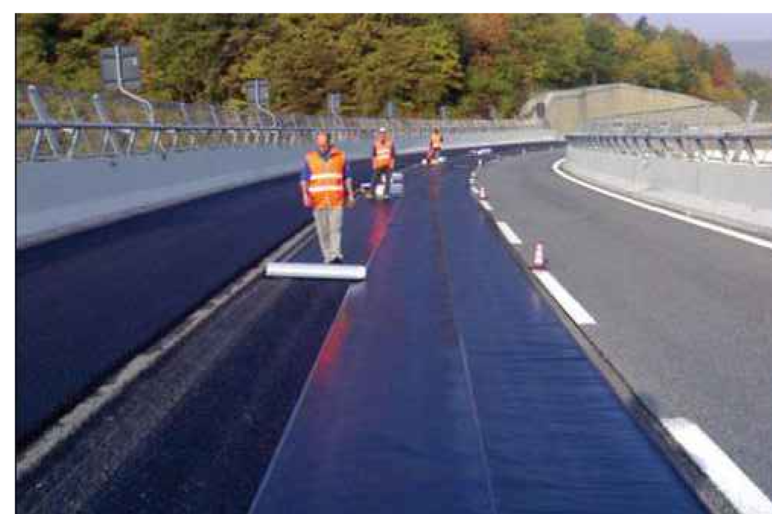
ESEMPIO APPLICATIVO DI UTILIZZO DI MEMBRANA BITUMINOSA RINFORZATA SU PAVIMENTAZIONE AUTOSTRADALE
