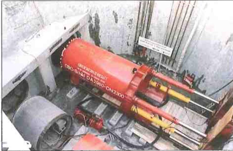
Fig. 2: Installazione della fresa e inizio della perforazione
