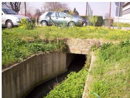
Figura 4-2 – Tombino di accesso ex stabilimento "Sun Chemicals"
