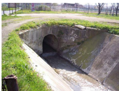
Figura 4-4 – Attraversamento Via delle Due Case
