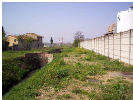
Figura 4-3 – Tombino in disuso senza funzionalità
