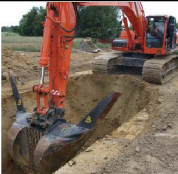
Figura 1-1 Scavo della trincea
