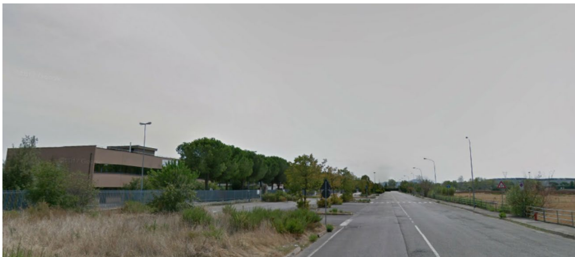
Figura 8 – Via S. Croce all'Osmannoro, sulla destra la zona dove verrà realizzata l'area di compensazione
