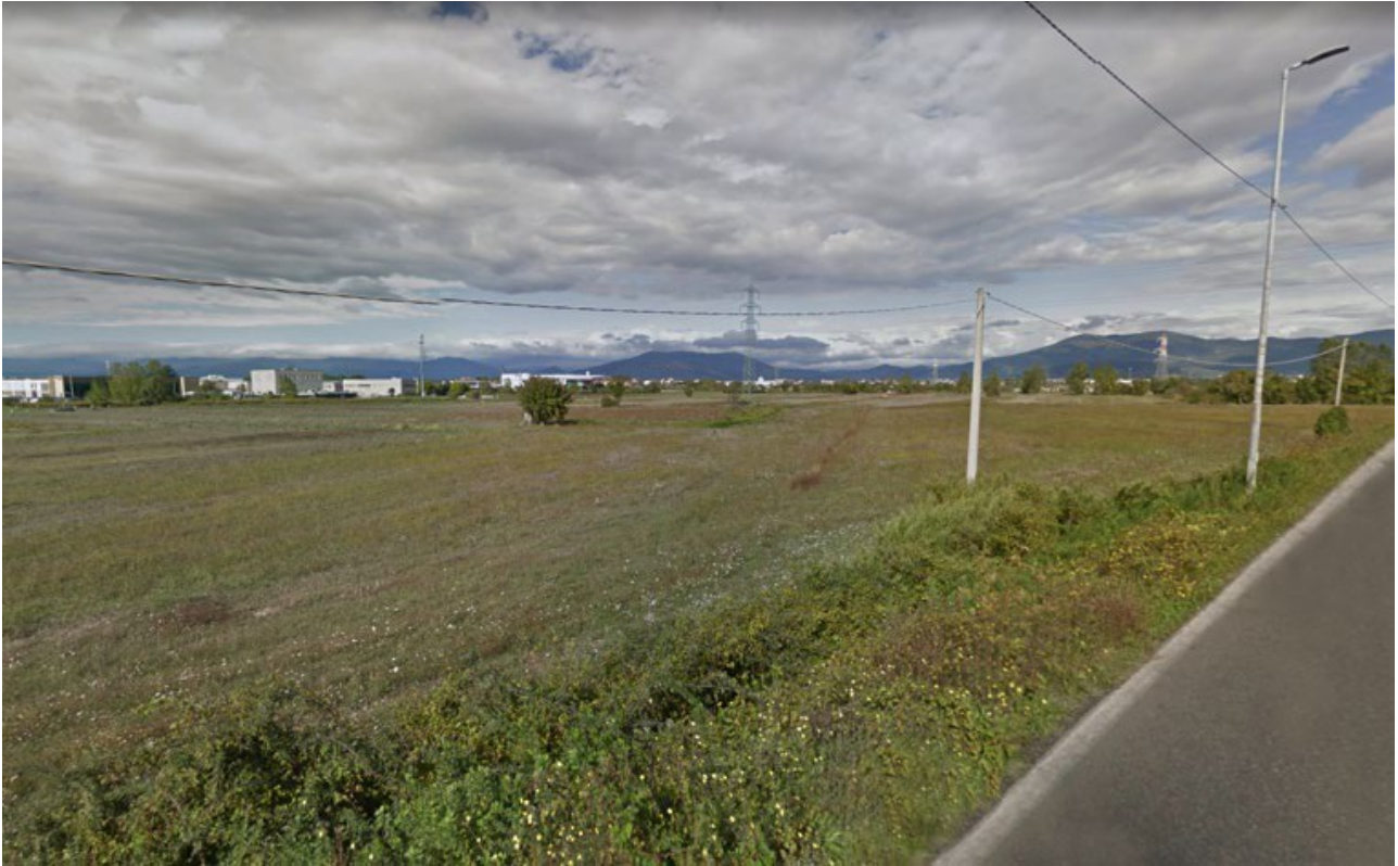
Figura 9.9 – Foto stato attuale da Via Argine Strada.
