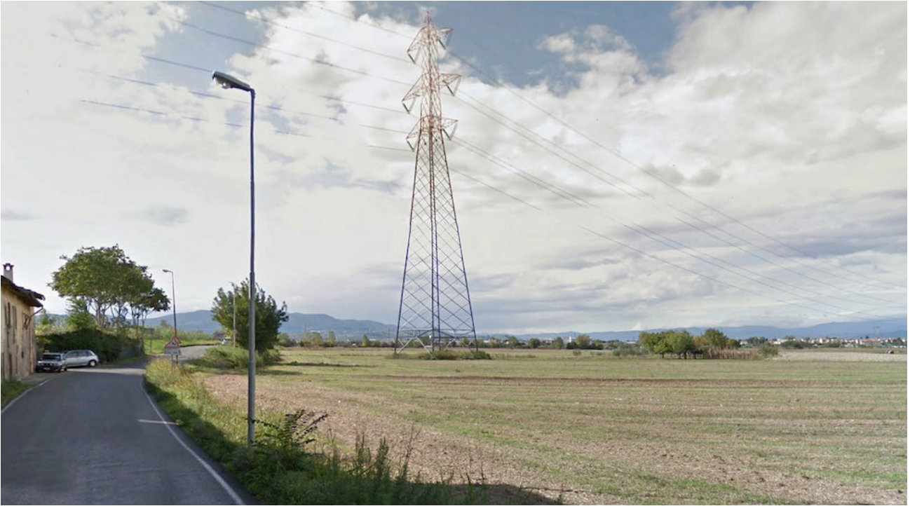
Figura 9.12 – Foto stato attuale da Via Argine Strada.
