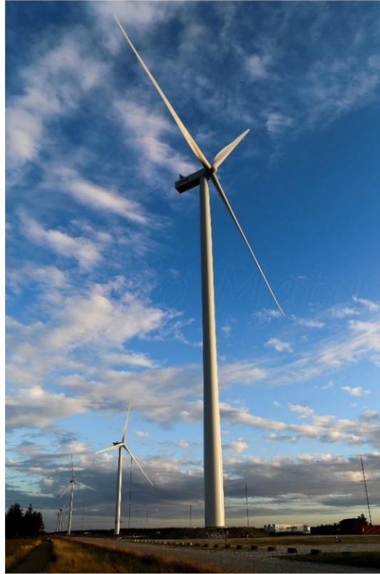
Figura 3 - Aerogeneratore Vestas V150
