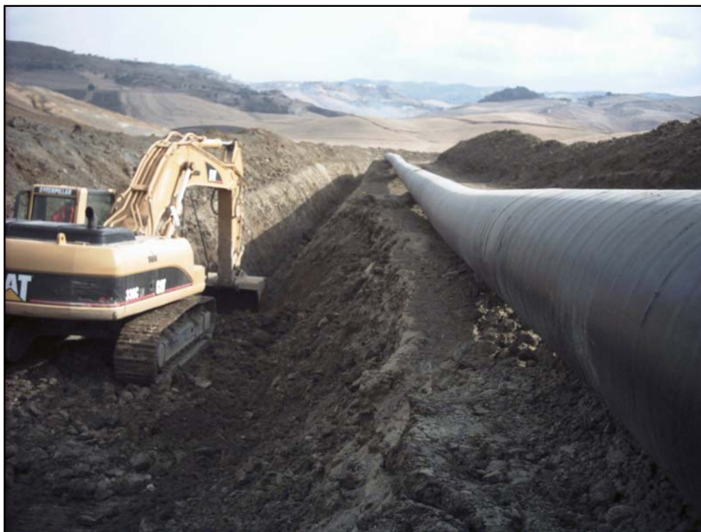
Fig. 11 - Attività di scavo della trincea
