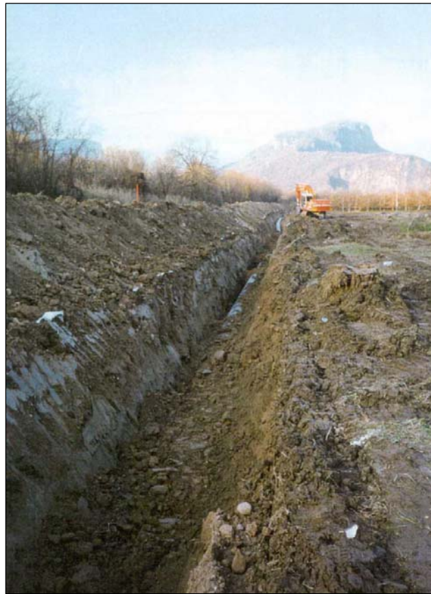
Fig. 13 - Operazioni di rinterro della condotta
