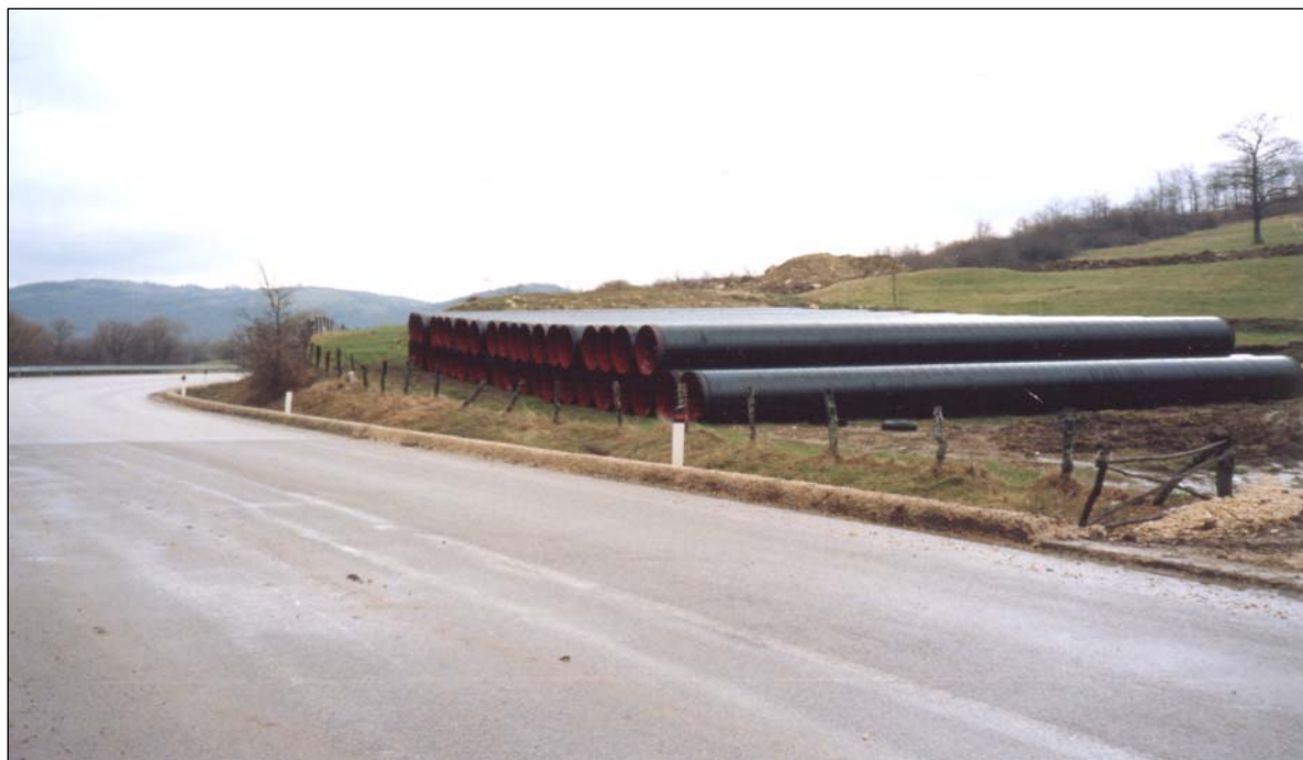
Fig. 6 - Piazzola accatastamento tubazioni
