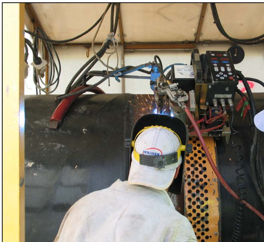
Fig. 10 - Attività di saldatura di linea
