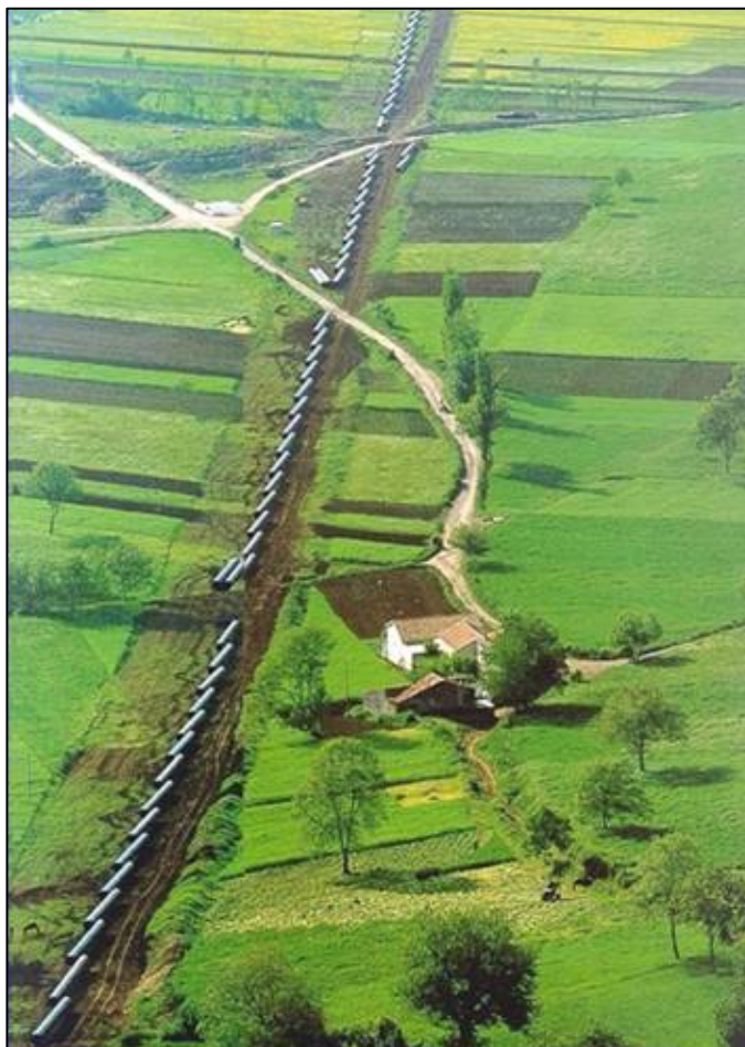
Fig. 9 - Sfilamento delle tubazioni e area di passaggio
