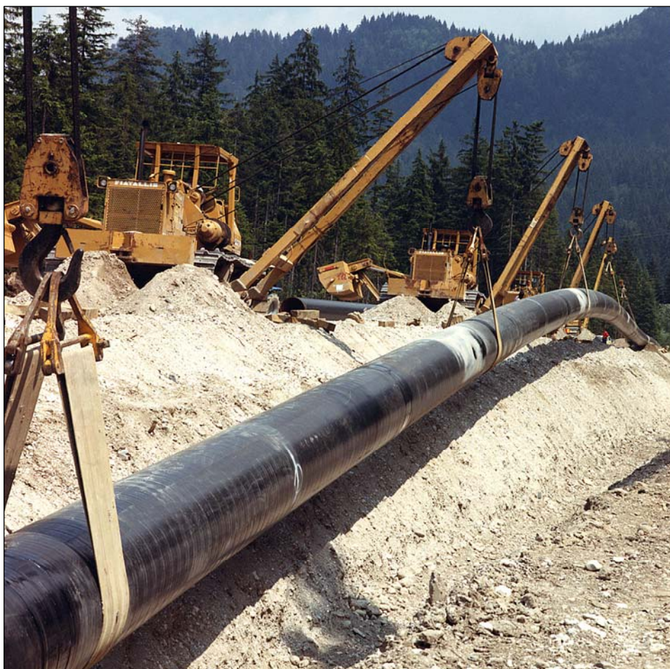
Fig. 12 - Attività di posa della condotta
