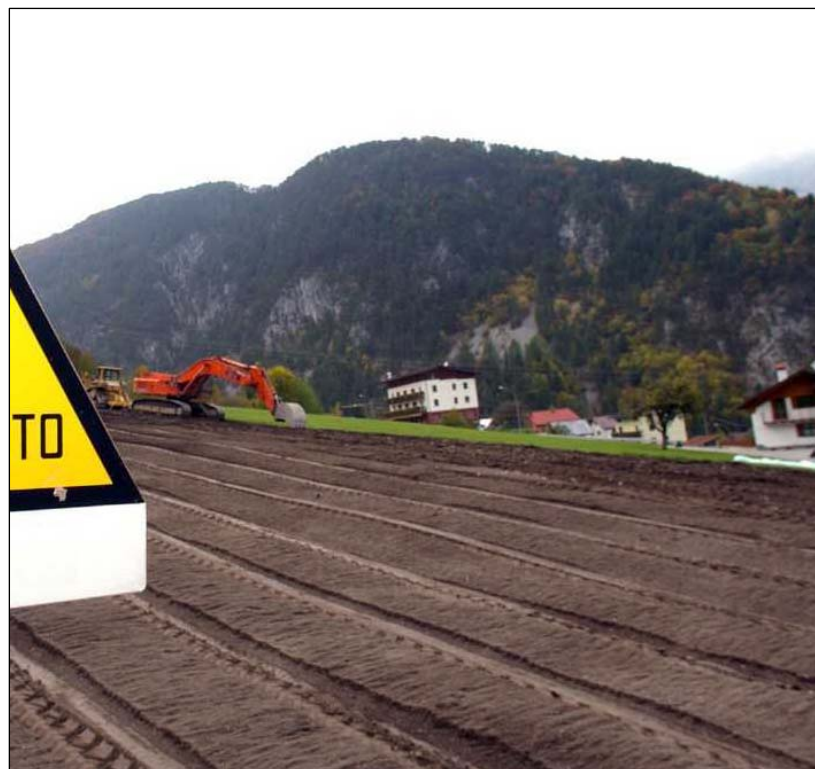
Fig. 14 - Ridistribuzione dello strato fertile superficiale precedentemente accantonato
