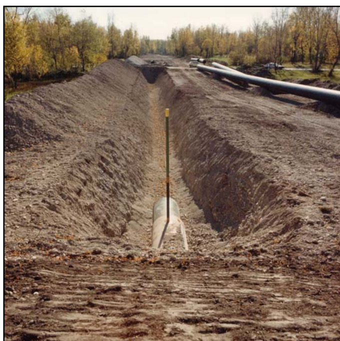
Fig. 15 - Particolare tubo di sfiato
