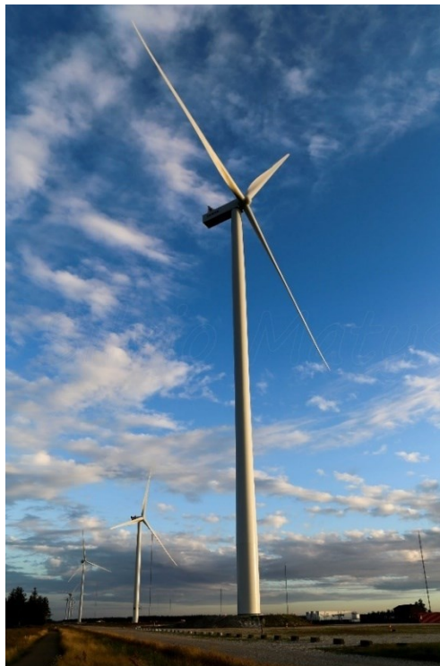
Figura 7 – Aerogeneratore Vestas V150
