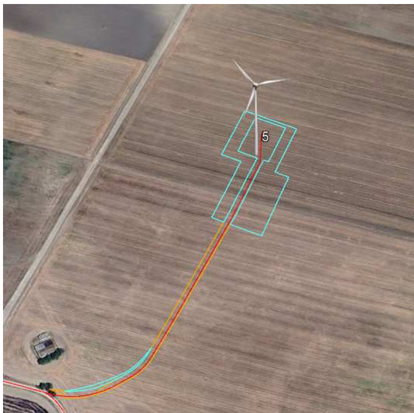
Sito di installazione WTG5 (Ortofoto 17/08/2023 - Google Earth)
