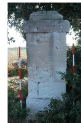
Muro orientato Est-Ovest. Il paramento Nord risulta in gran parte non visibile a causa di alberi e arbusti che si addossano alla struttura muraria. Il paramento Sud risulta non visibile nella parte finale verso Ovest per la presenza anche in questo caso di arbusti. Le pietre che costituiscono il paramento sono di diverse pezzature e di forma irregolare con spigoli non vivi. Entrambi i paramenti, hanno uguale tessitura.
