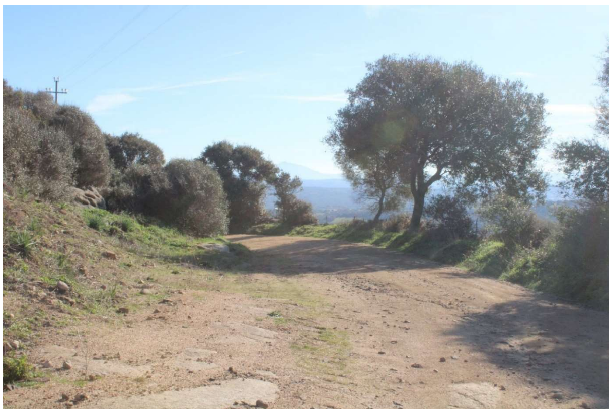
Area dell'elettrodotto URE_MIS_01
