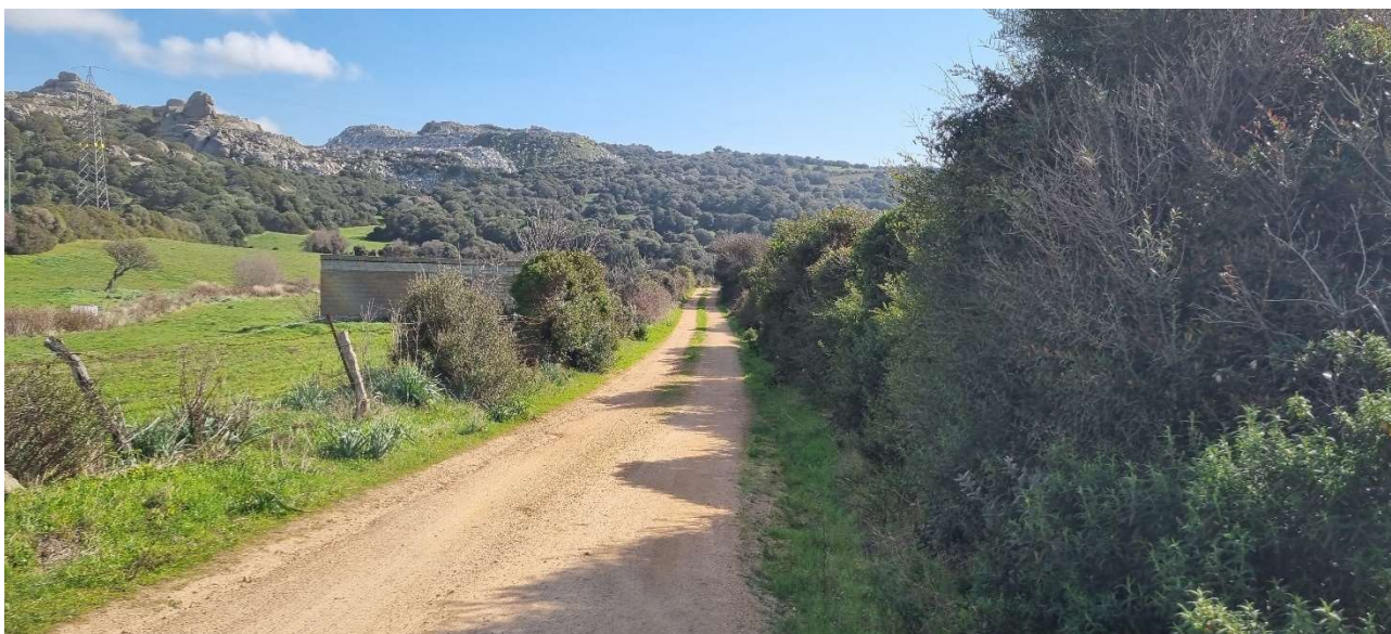
Area dell'elettrodotto URE_MIS_03
