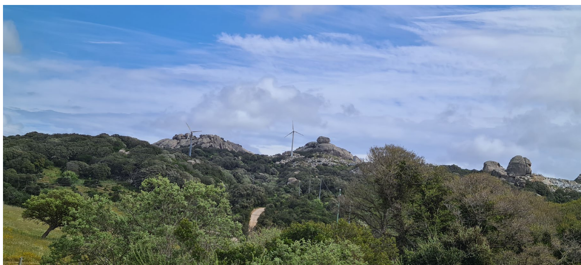
Figura 4-16: Impianti eolici su macchia alta e affioramenti granitici.
