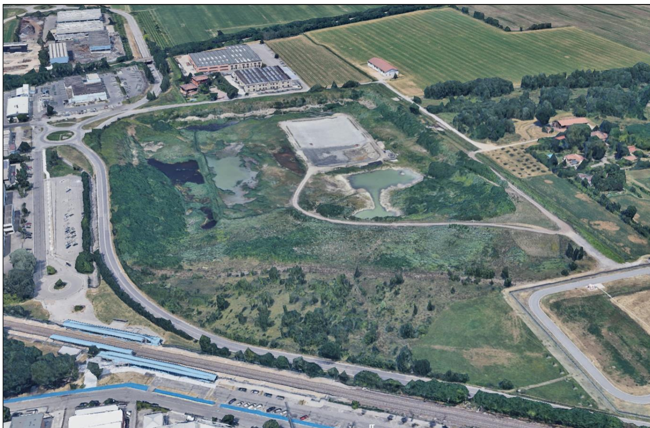
Figura 1 – Vista d'insieme dell'area di Cava Olmi
