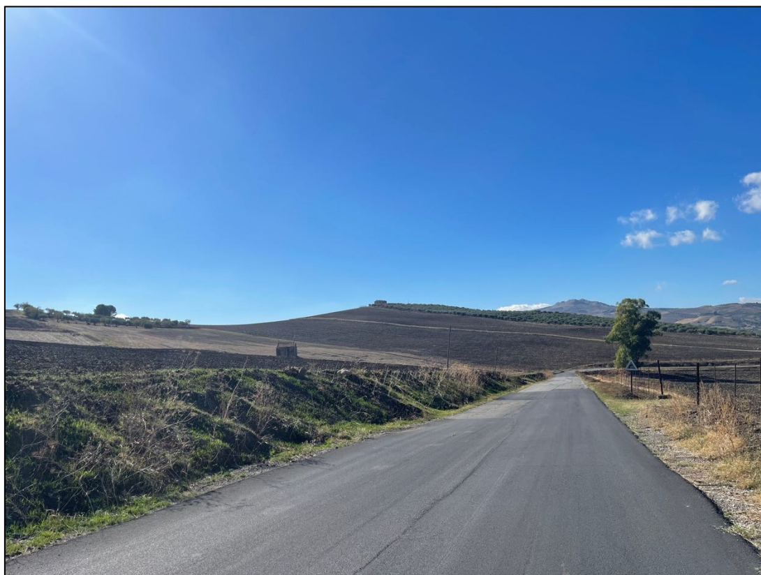
Foto 31 - Panoramica UR 07 (cavidotto)
