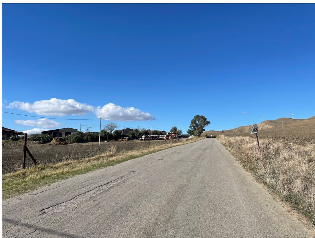
Foto 30 - Panoramica UR 07 (cavidotto)
