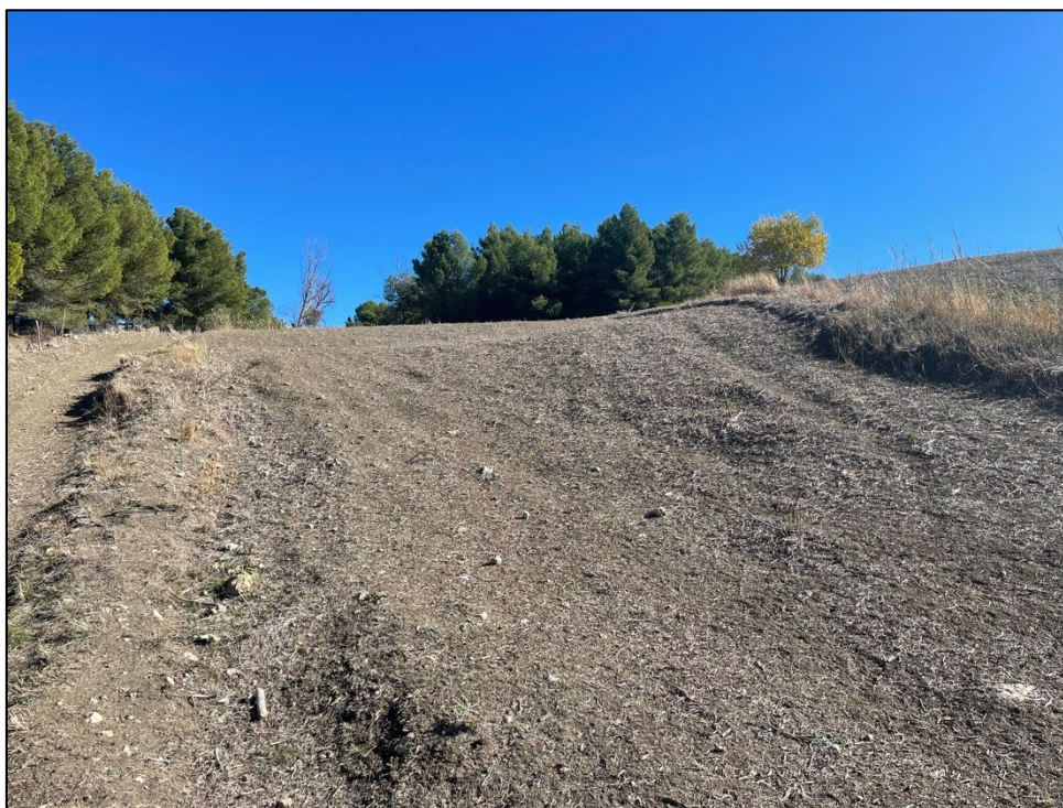
Foto 2 - Panoramica UR 01 (Impianto)
