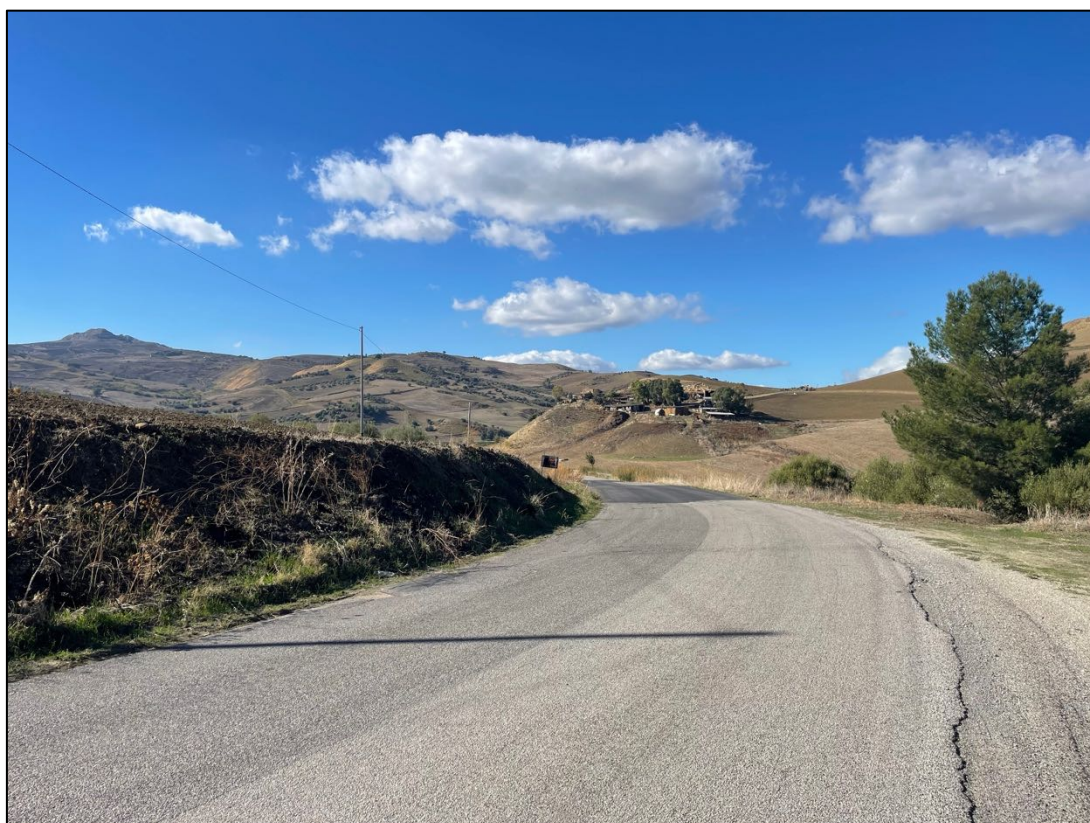
Foto 32 - Panoramica UR 07 (cavidotto)
