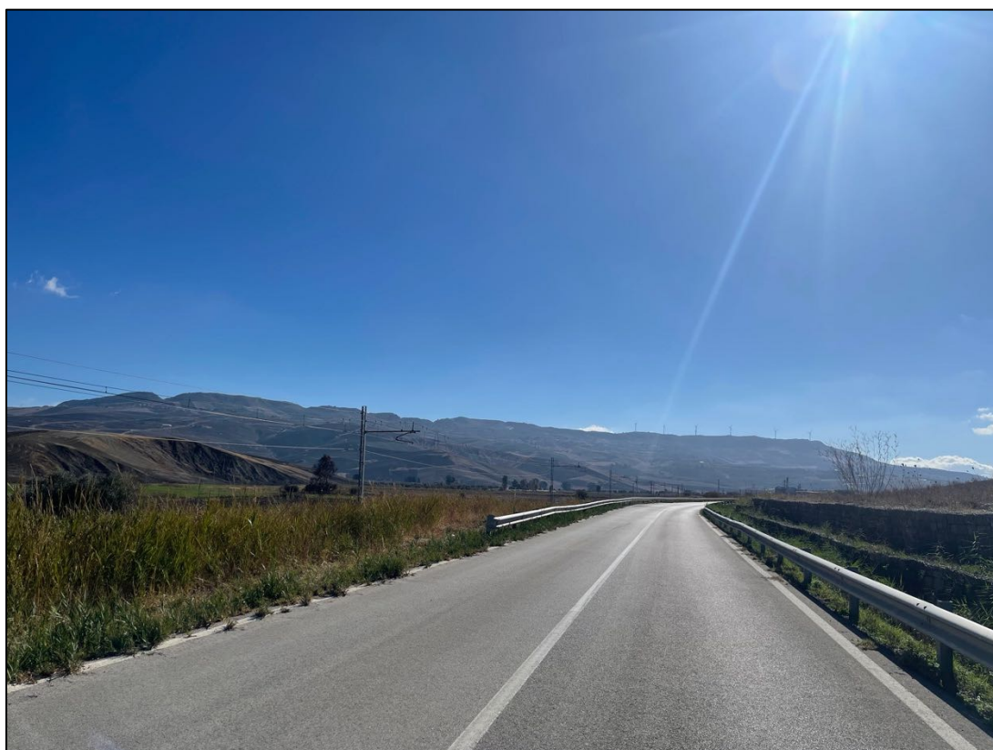
Foto 34 - Panoramica UR 08 (cavidotto)
