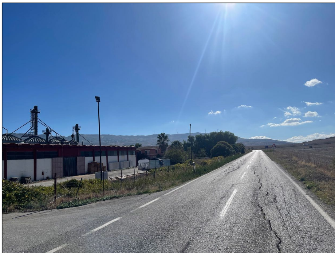
Foto 35 - Panoramica UR 08 (cavidotto)
