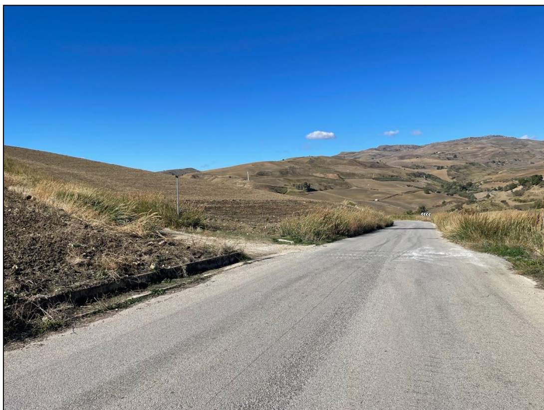
Foto 22 - Panoramica UR 06 (cavidotto)
