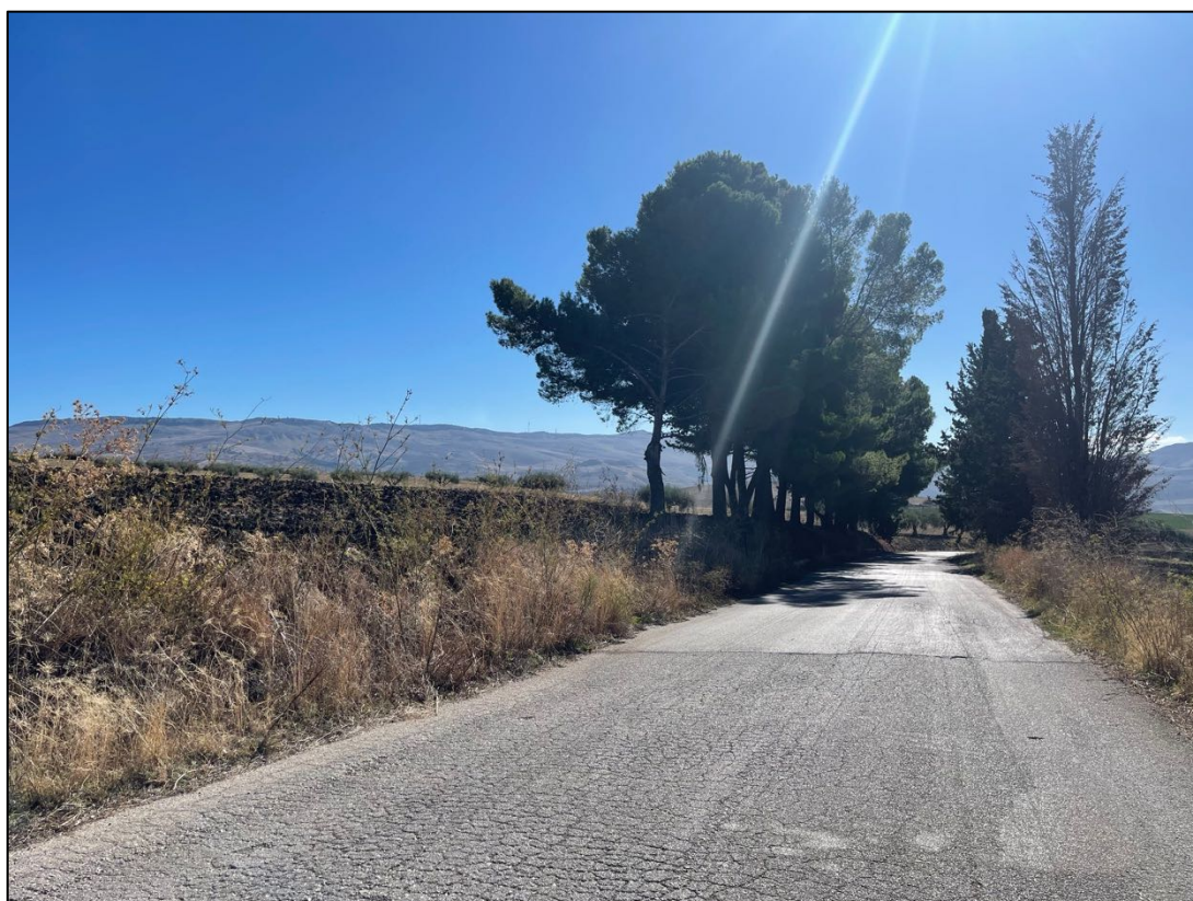
Foto 26 - Panoramica UR 06 (cavidotto)
