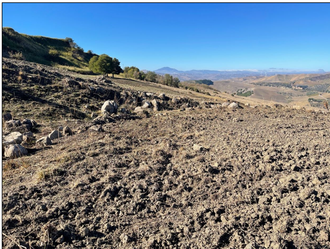
Foto 10 - Panoramica UR 03 (Impianto)
