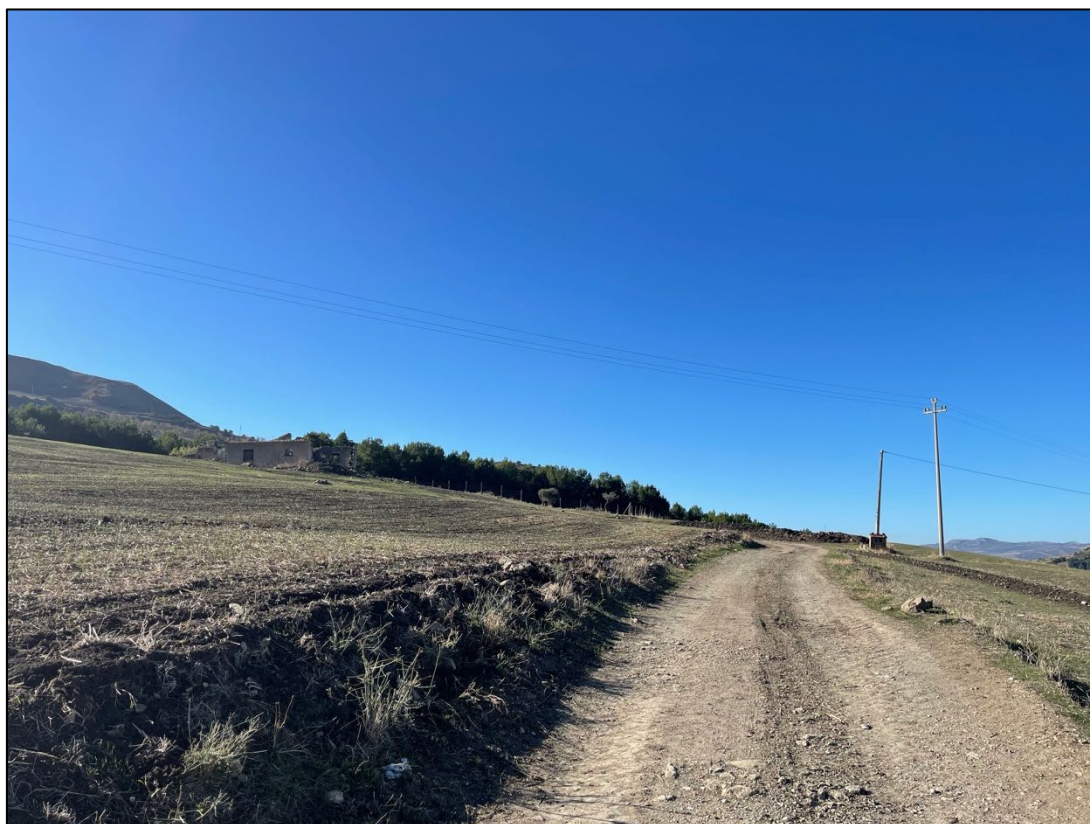
Foto 21 - Panoramica UR 05 (cavidotto)
