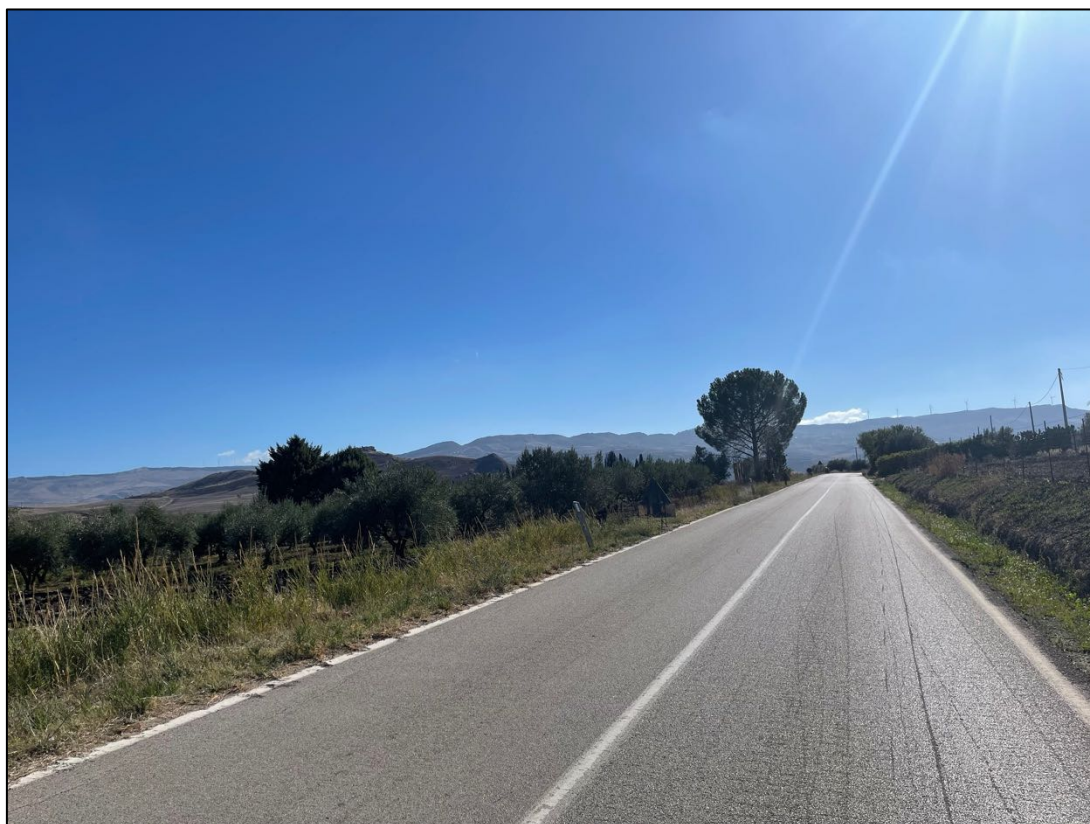
Foto 33 - Panoramica UR 08 (cavidotto)
