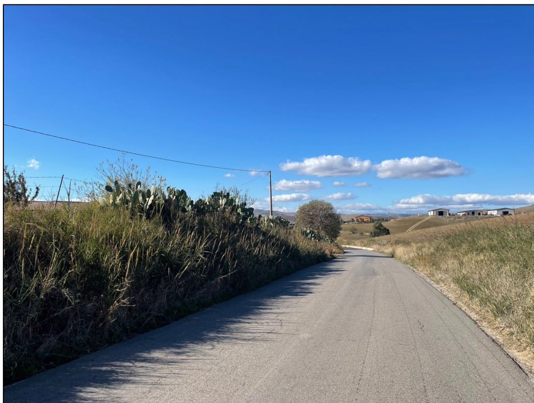
Foto 29 - Panoramica UR 07 (cavidotto)
