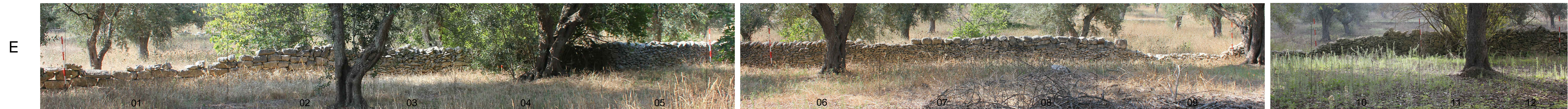
prospetto generale nord
