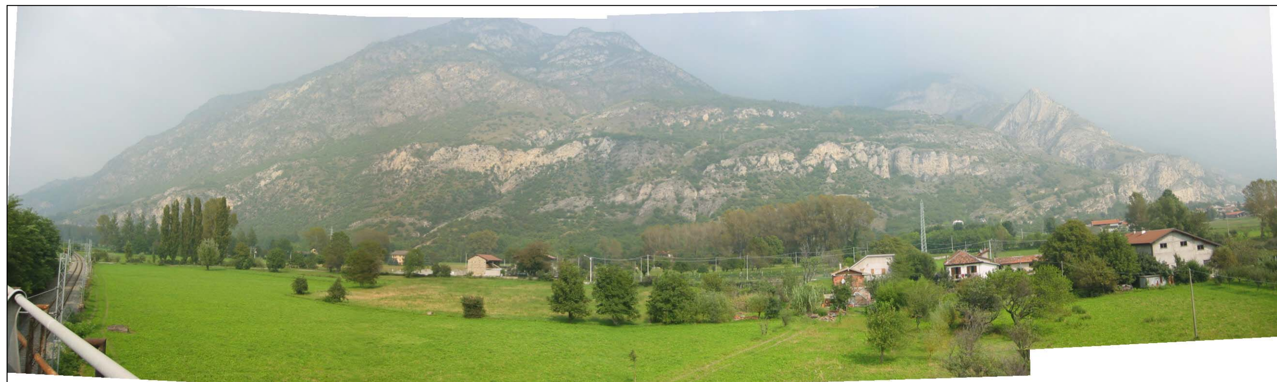
Vista dalla SS 25 dell'area di cantiere di Foresto
