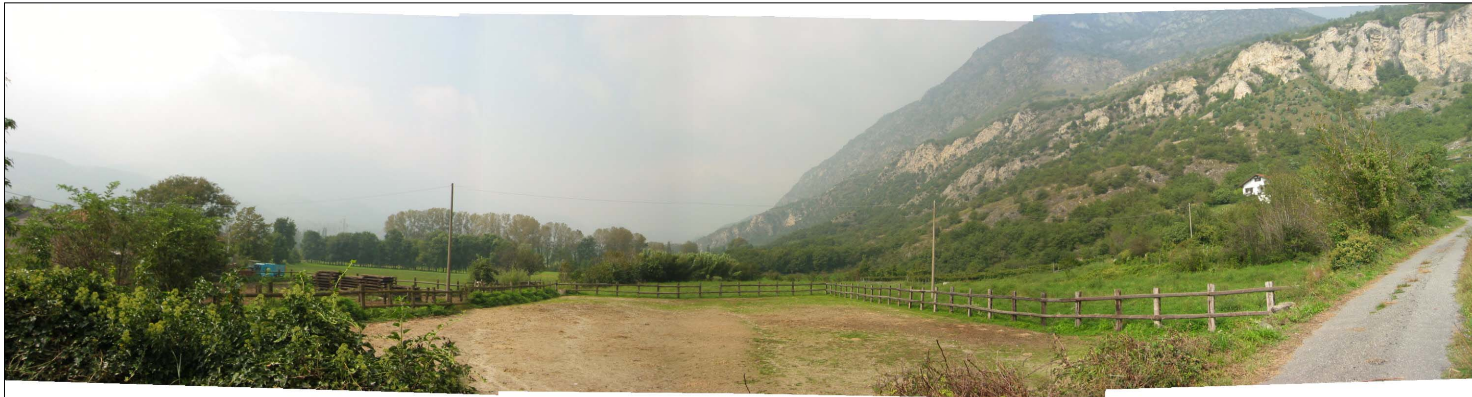
Cantiere e zona di lavorazione di Foresto: parte vicina all'attacco della Finestra. La casa bianca è dentro la Riserva Naturale.
