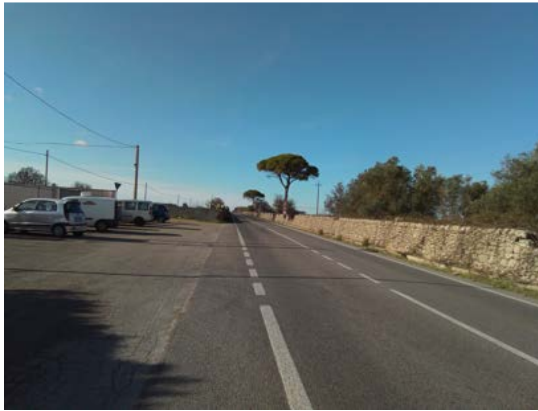
Area infrastrutturata lungo la strada interessata dalle lavorazioni
