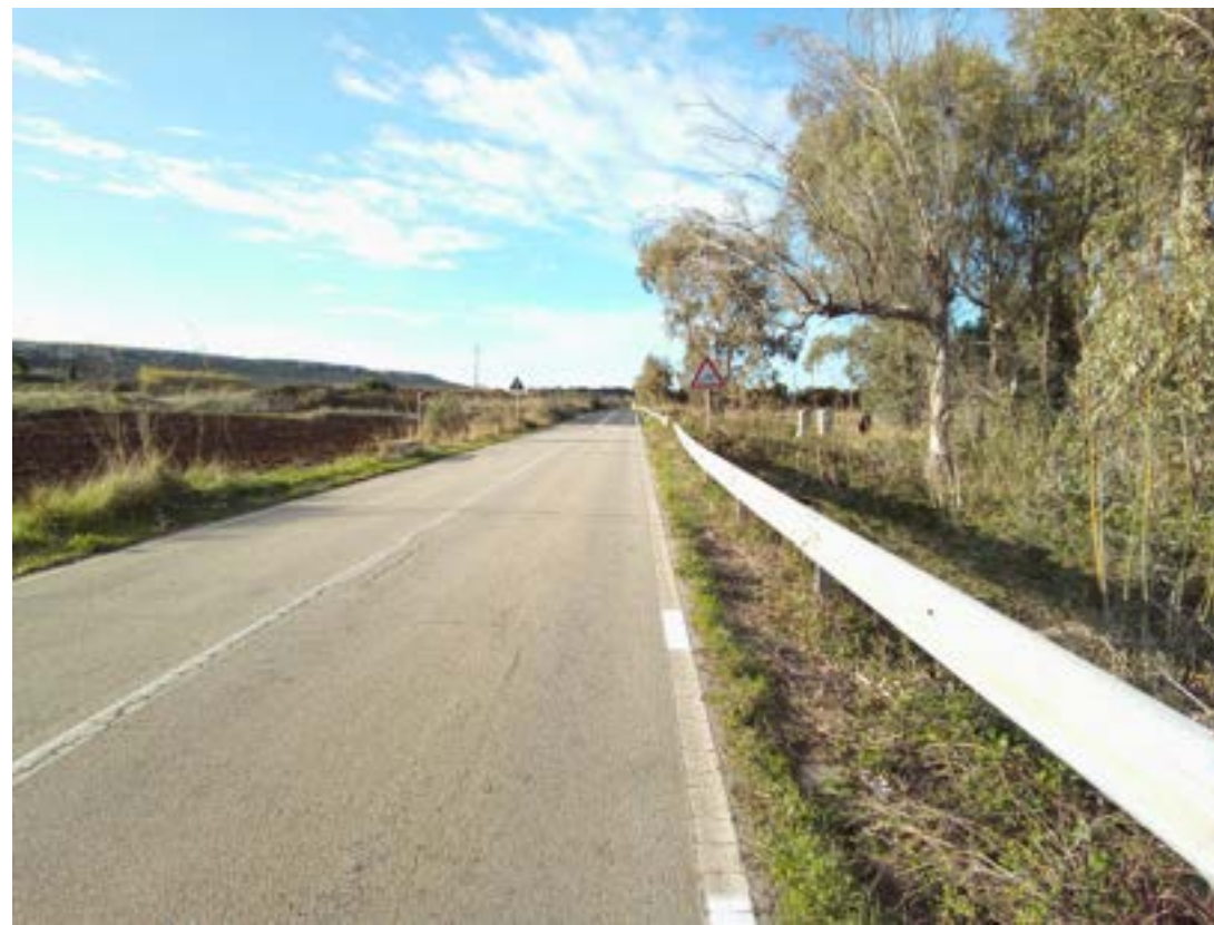
Area ai lati del tratto iniziale dell'elettrodotto
