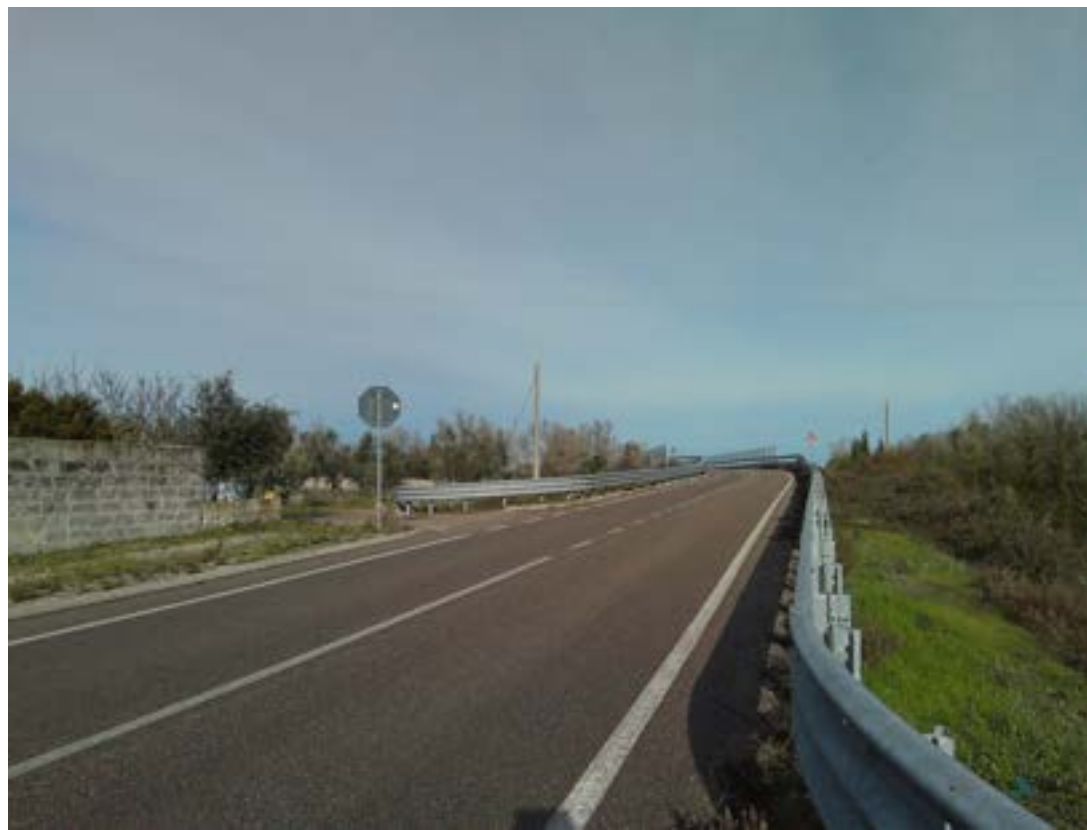
Asse stradale interessato dalle lavorazioni
