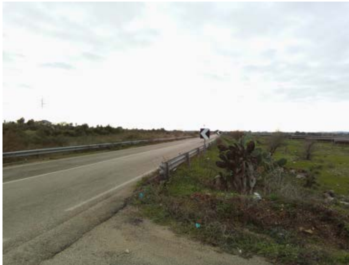
Tratto stradale interessato dalle lavorazioni
