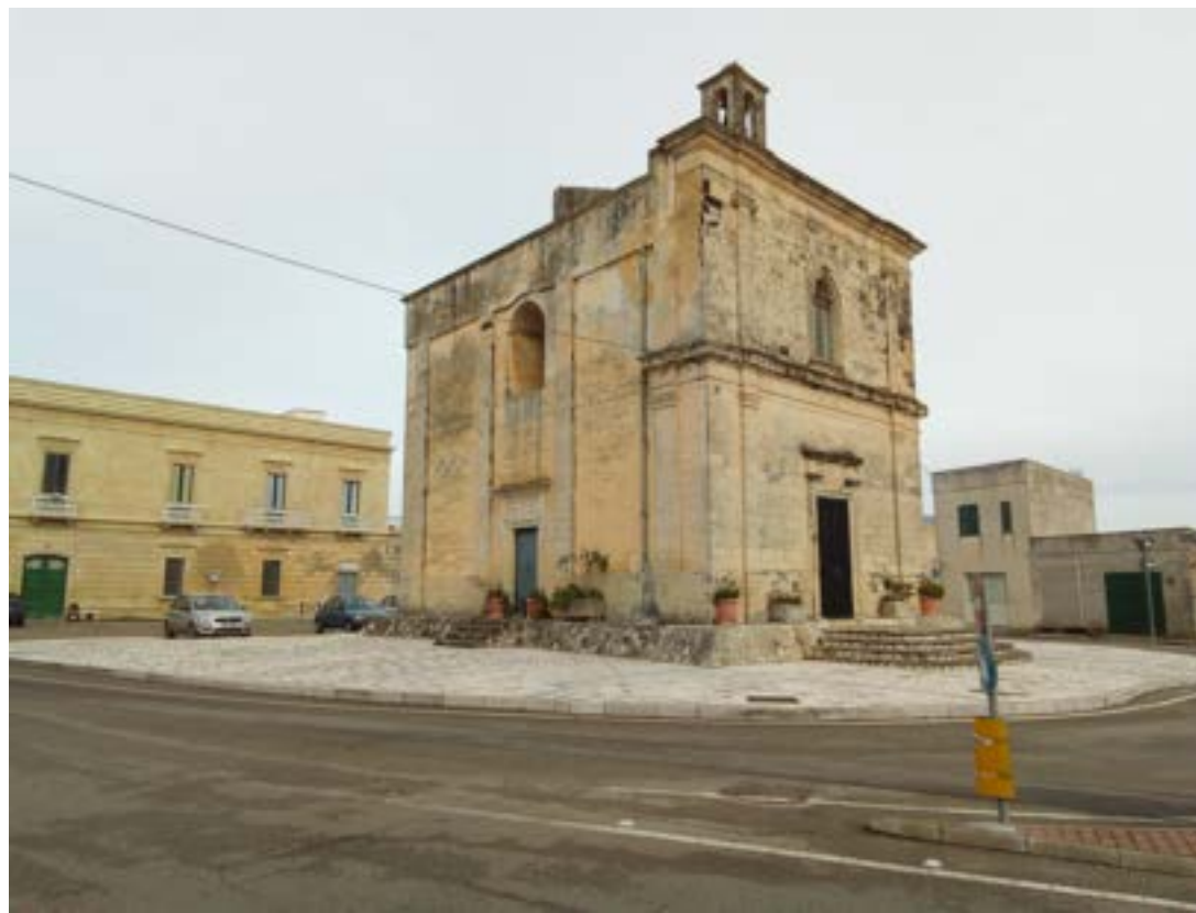
Centro urbano nel punto di passaggio dell'infrastruttura
