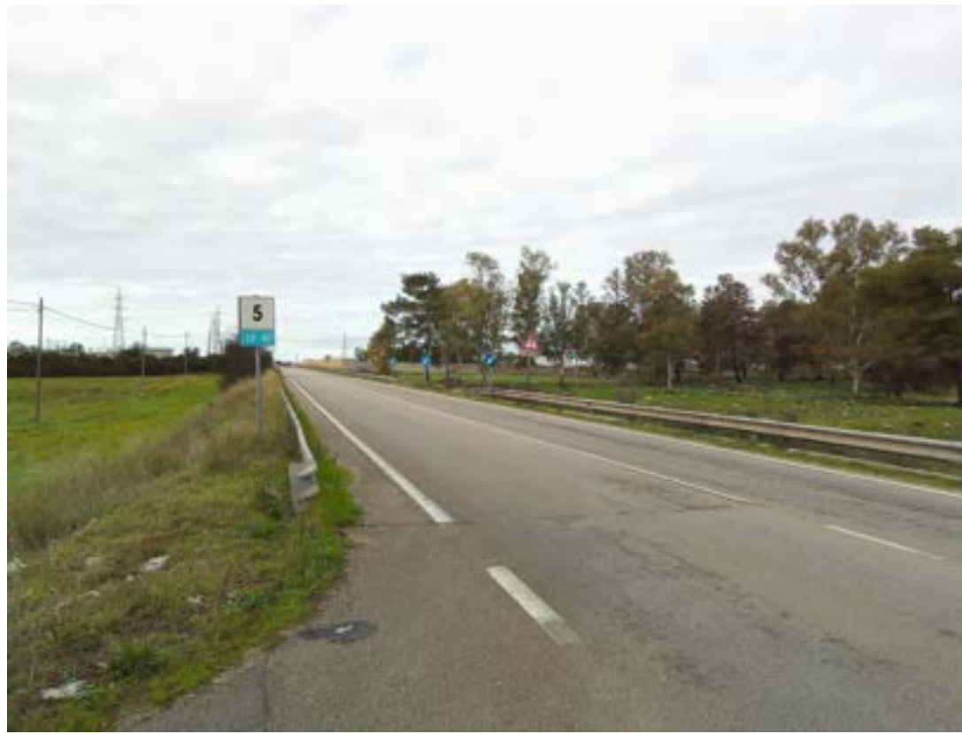
Tratto di strada interessato dalle lavorazioni
