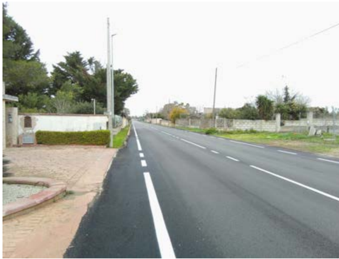
Tratto stradale interessato dalle lavorazioni
