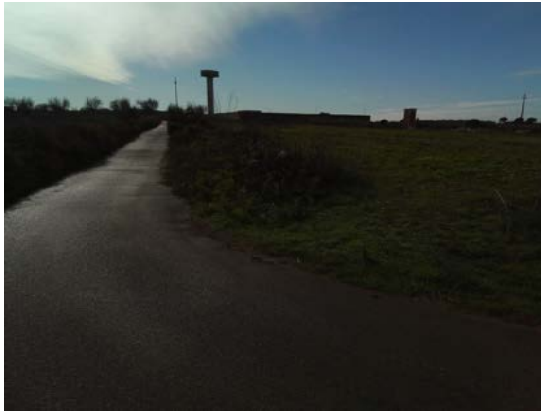
Strada in area campestre interessata dalle lavorazioni
