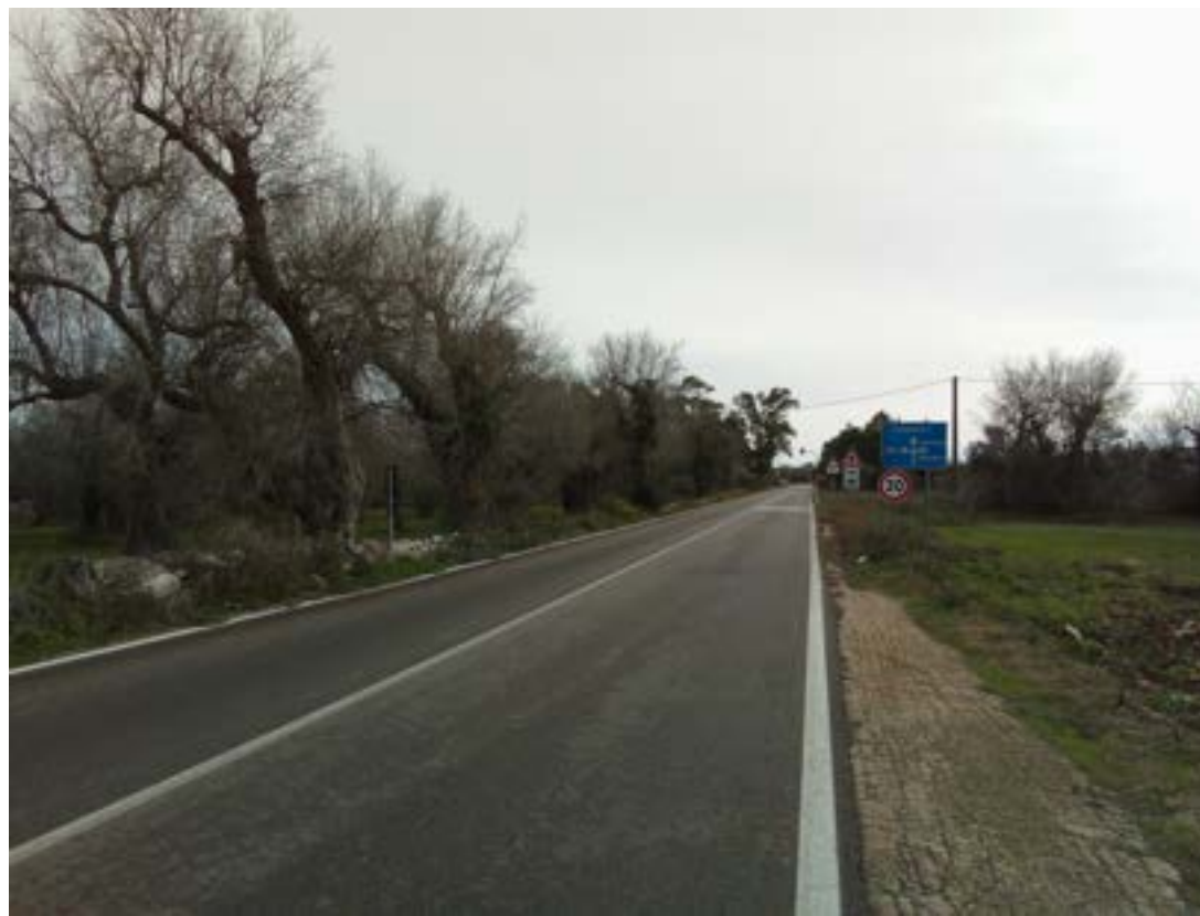
Asse stradale interessato dalle lavorazioni
