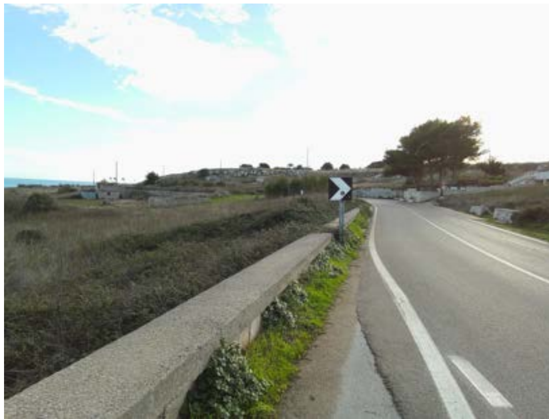
Area ai lati del tratto iniziale dell'elettrodotto
