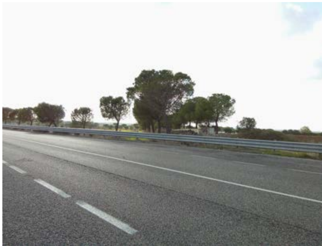
Infrastruttura stradale interessata dalle lavorazioni
