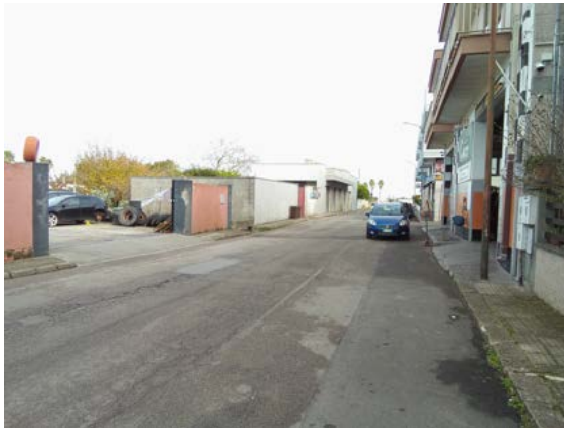
Area urbanizzata in corrispondenza della strada interessata dalle lavorazioni
