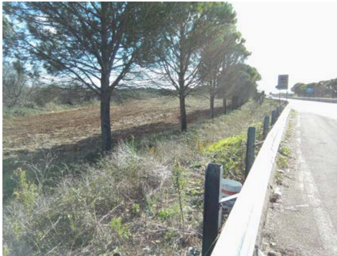
Infrastruttura stradale interessata dalle lavorazioni
