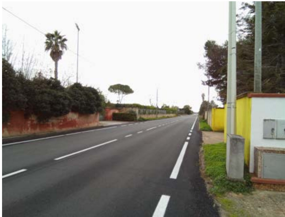
Tratto stradale interessato dalle lavorazioni
