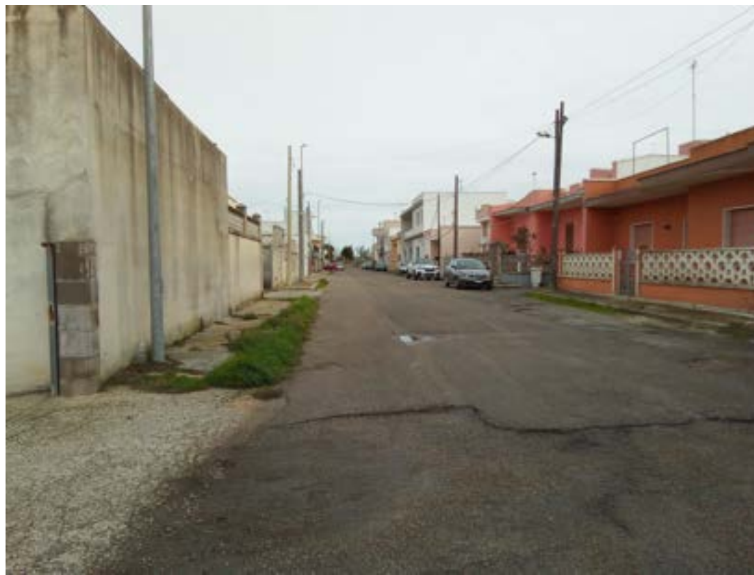
Asse stradale interessato dalle lavorazioni in zona urbanizzata
