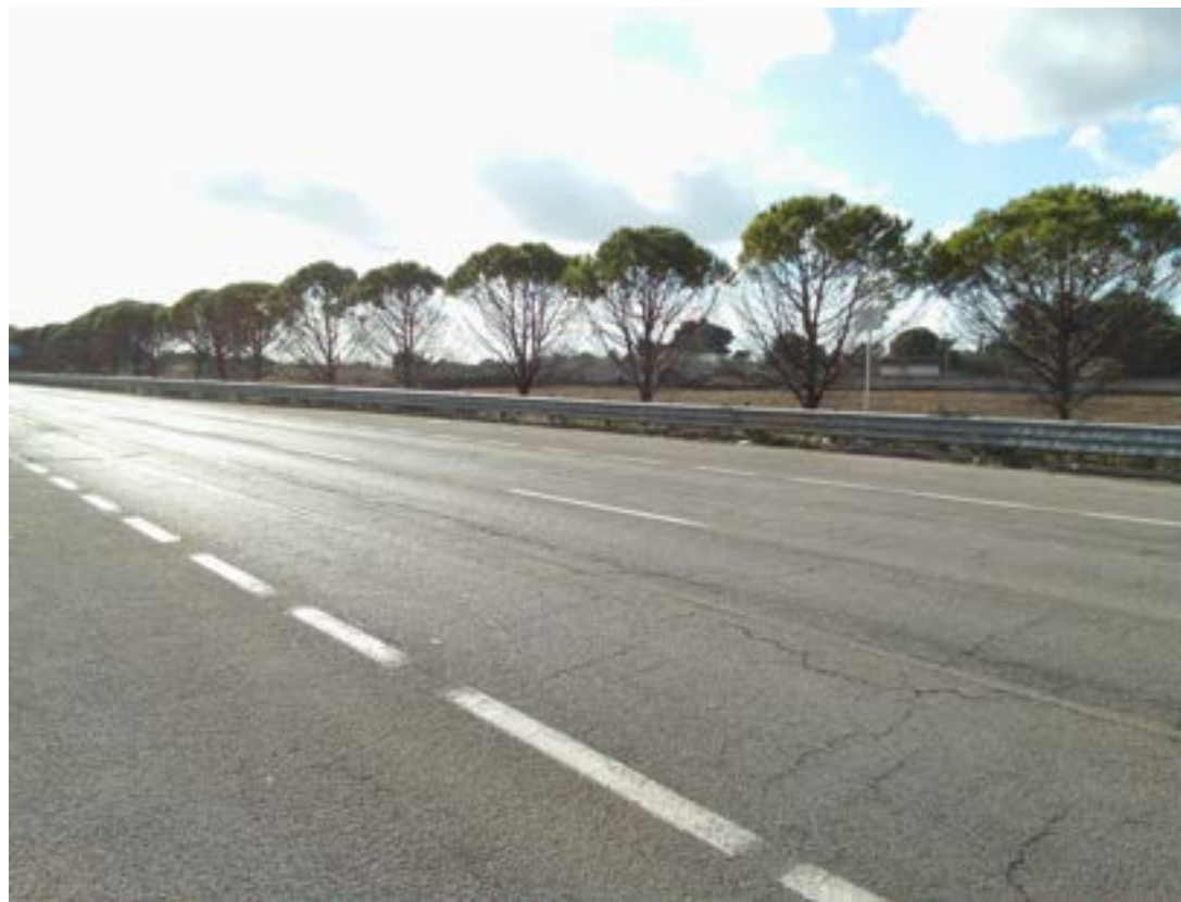
Infrastruttura stradale interessata dalle lavorazioni
