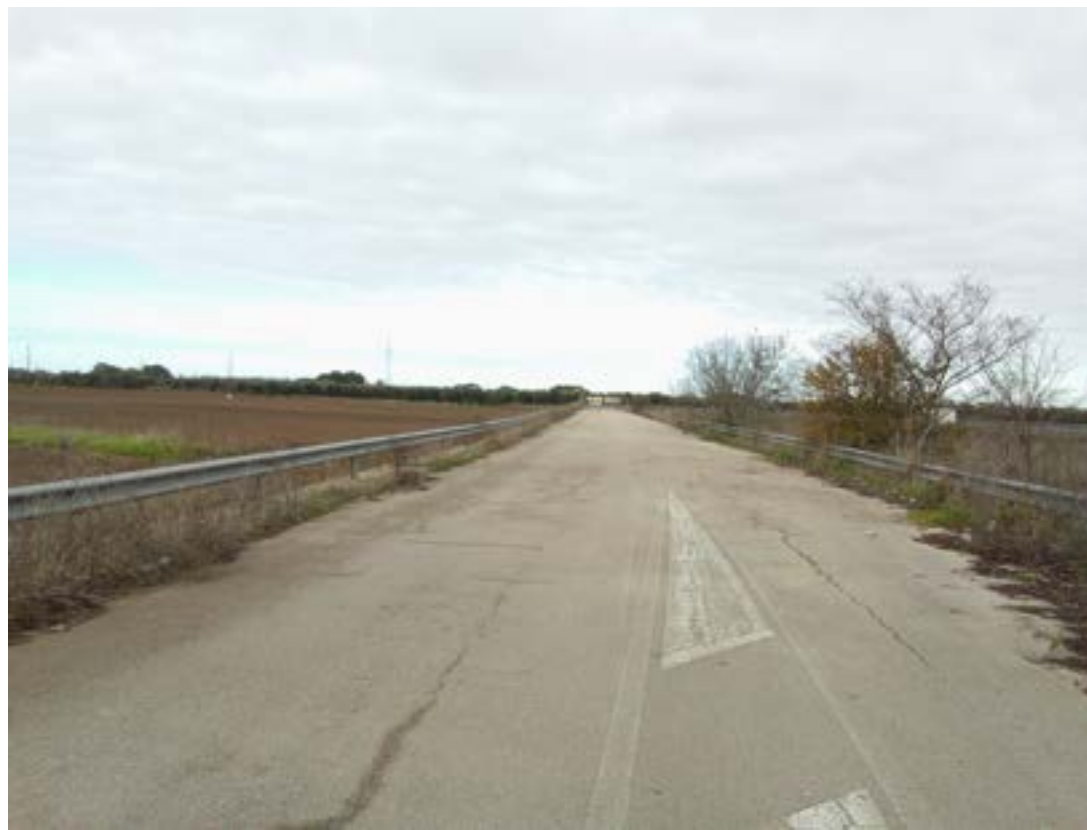
Infrastruttura stradale dismessa interessata dalle lavorazioni
