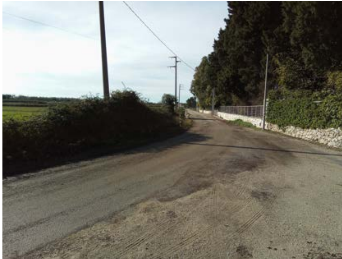
Area infrastrutturata a lato del percorso dell'elettrodotto
