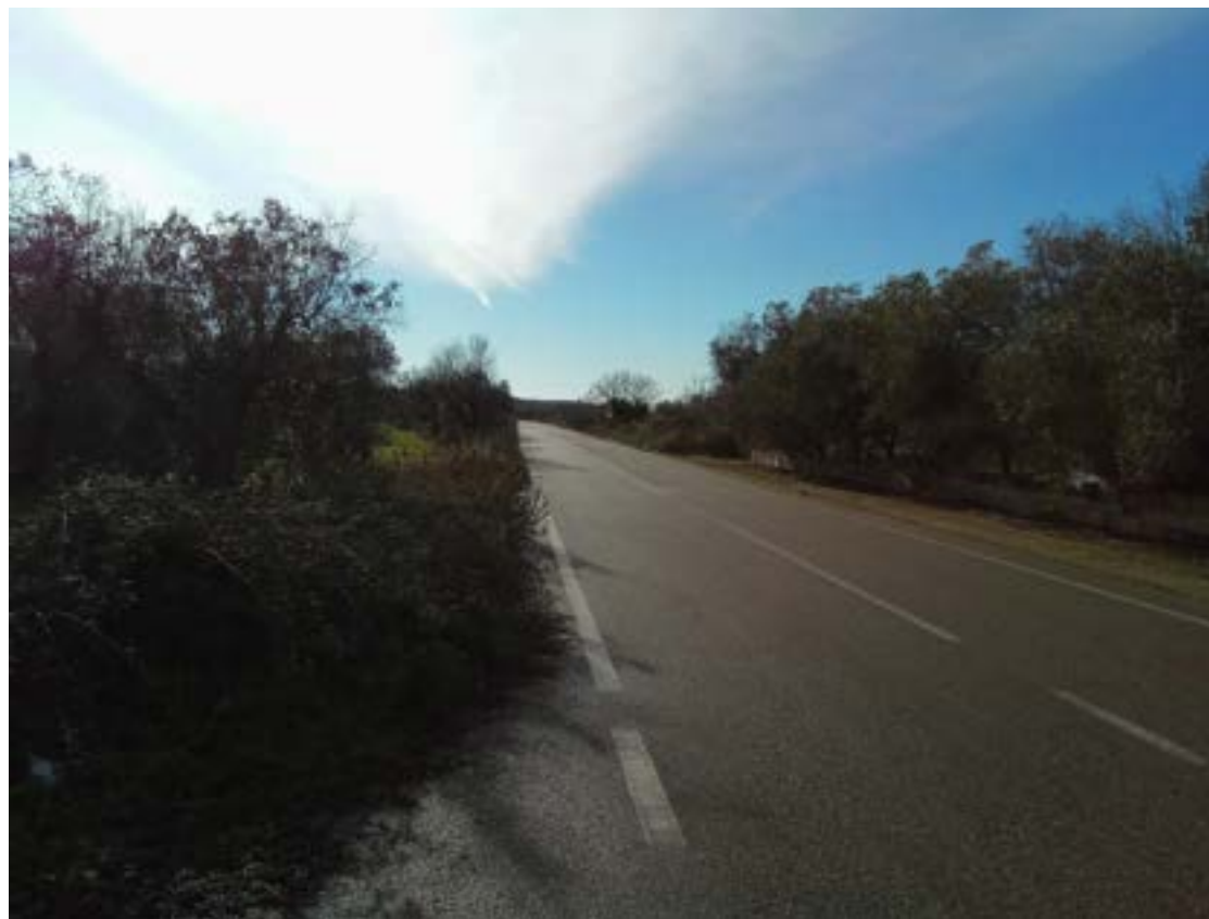
Asse stradale interessato dalle lavorazioni
