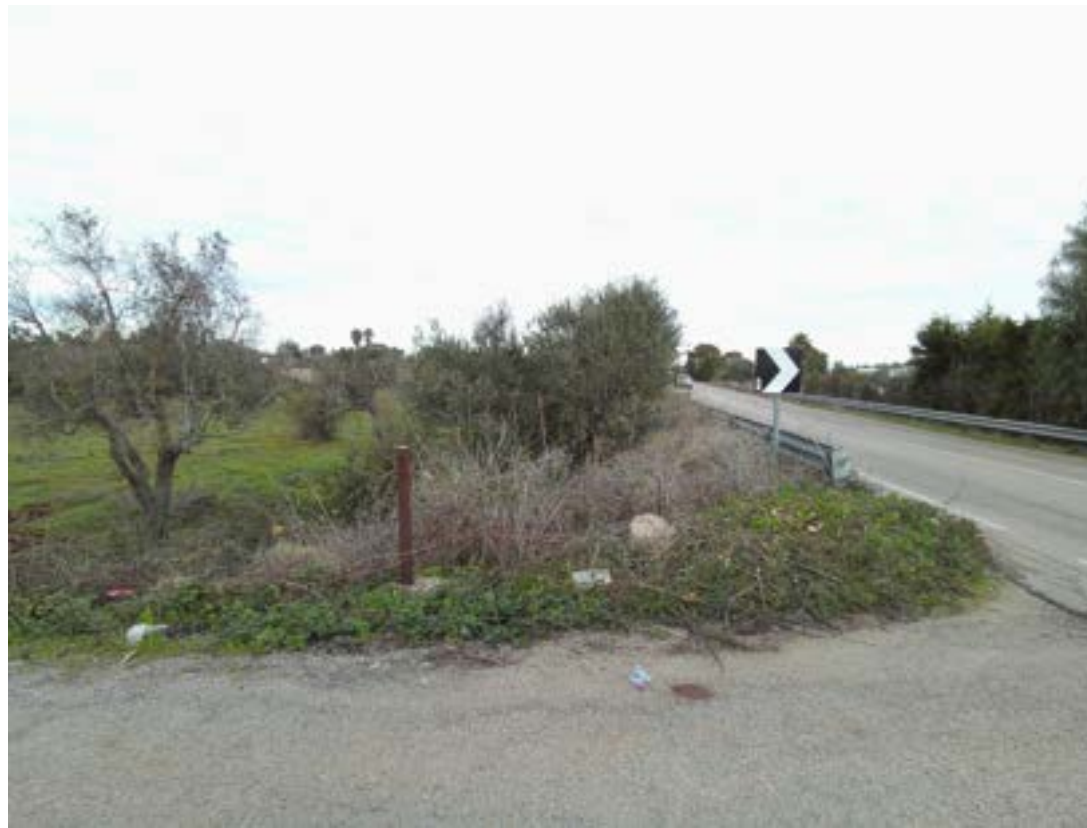
Tratto stradale interessato dalle lavorazioni
