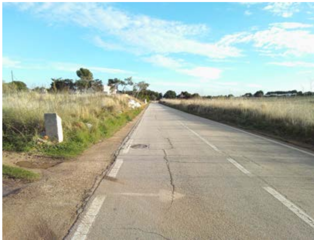
Area ai lati del tratto iniziale dell'elettrodotto
