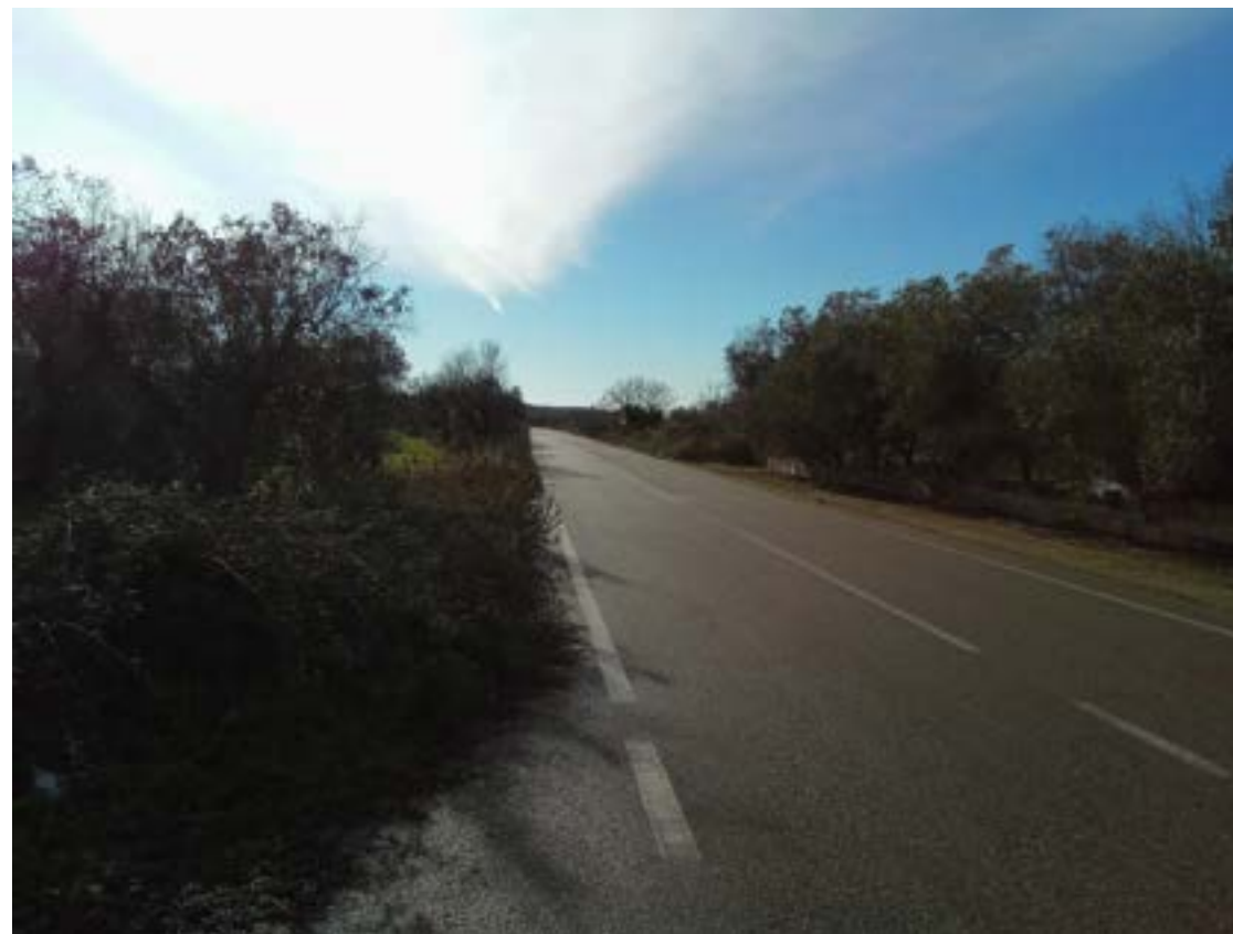
Asse stradale interessato dalle lavorazioni
