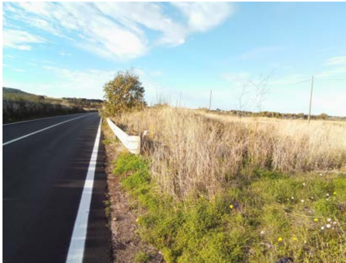
Area ai lati del tratto iniziale dell'elettrodotto
