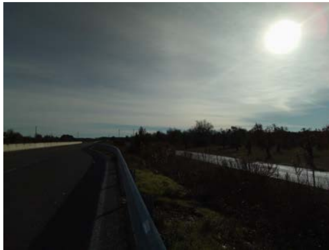
Asse stradale interessato dalle lavorazioni
