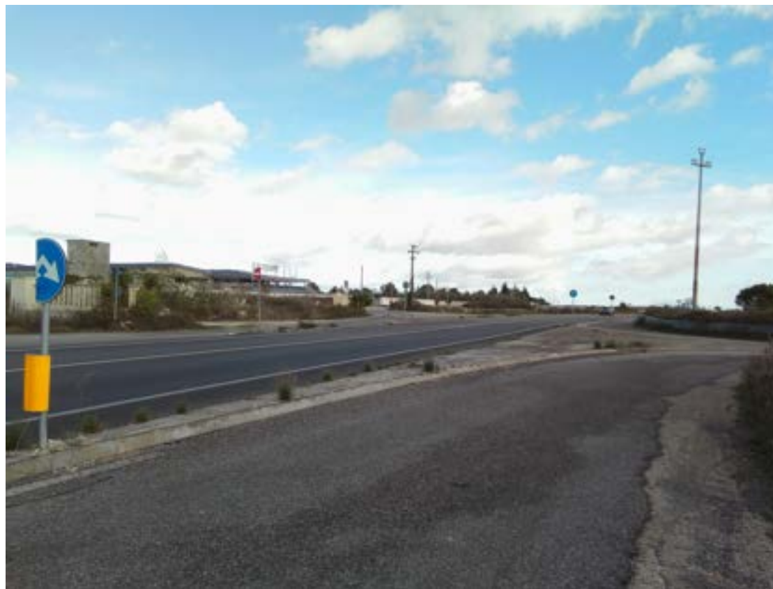
Area produttiva accanto all'asse stradale interessato dalle lavorazioni
