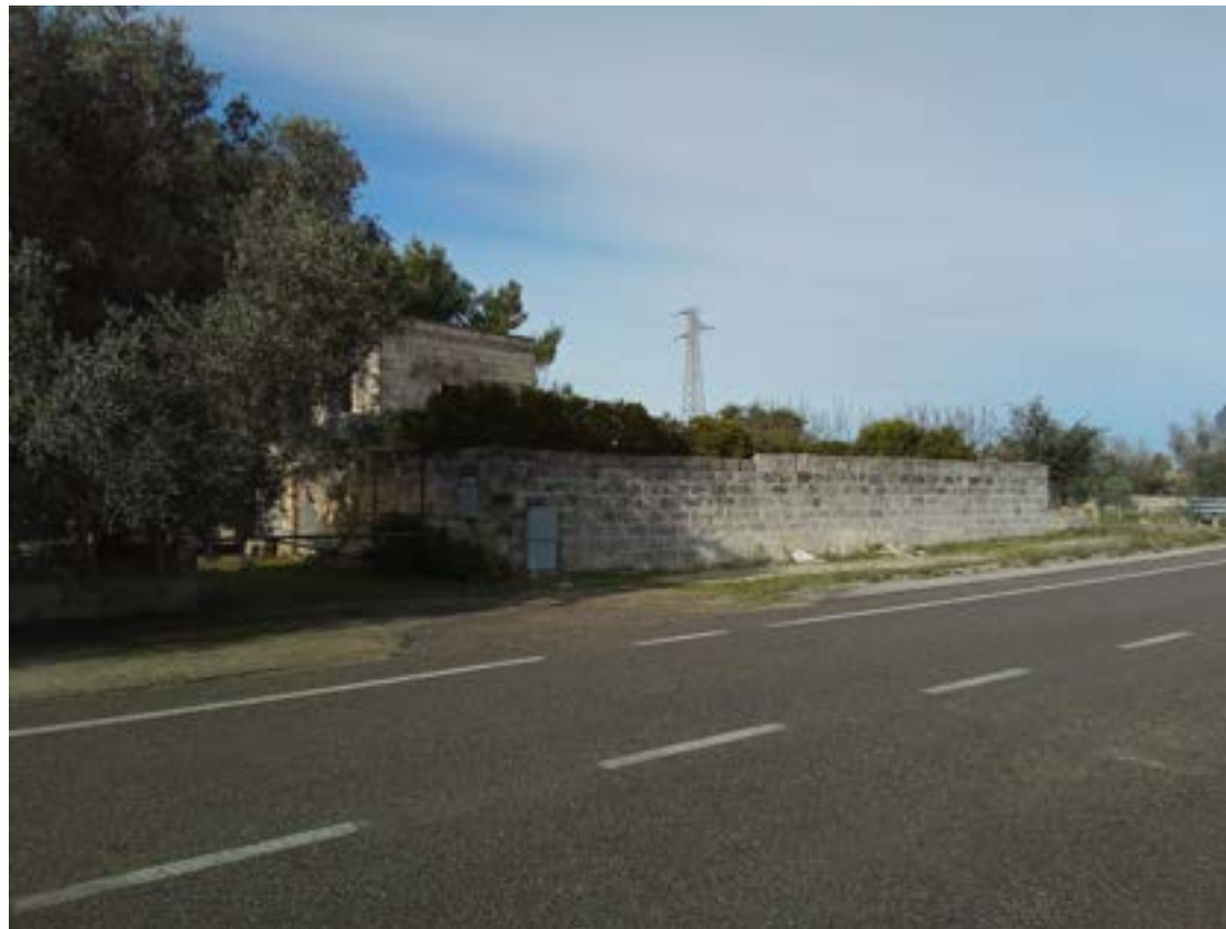
Asse stradale interessato dalle lavorazioni
