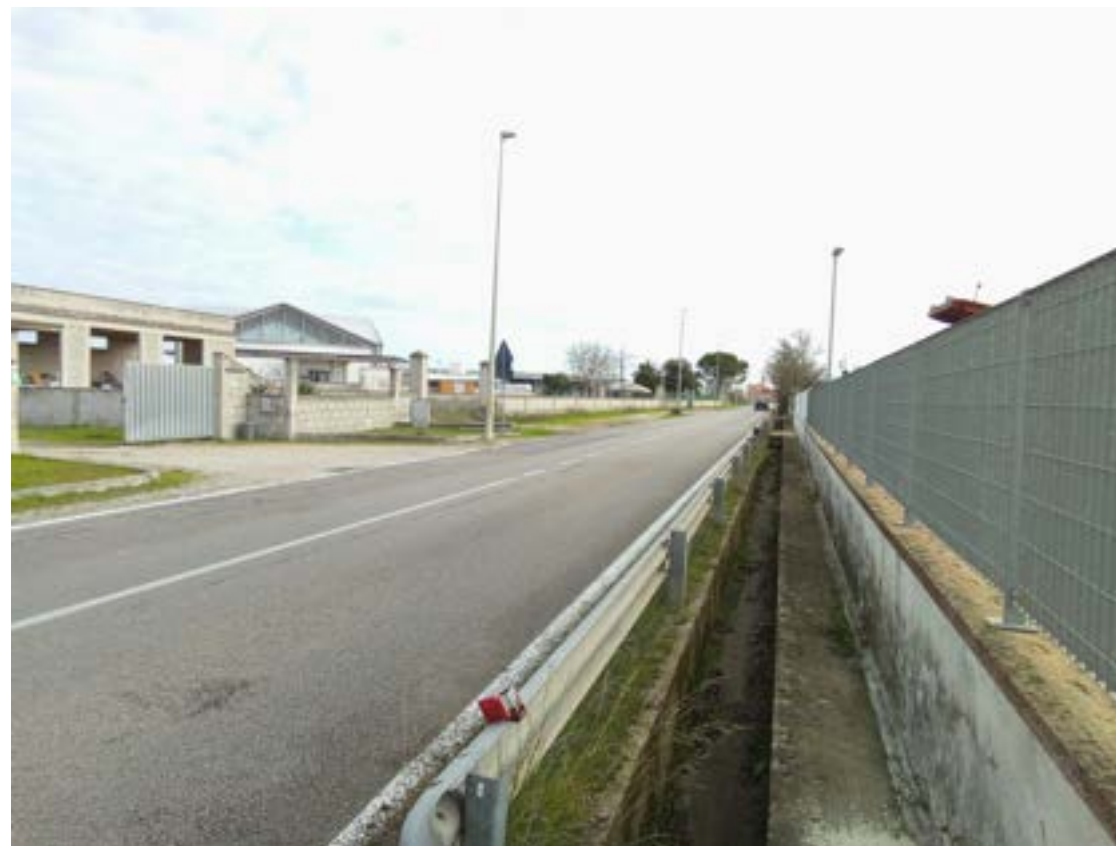
Aree cintate e edificate ai lati della strada interessata dalle lavorazioni
