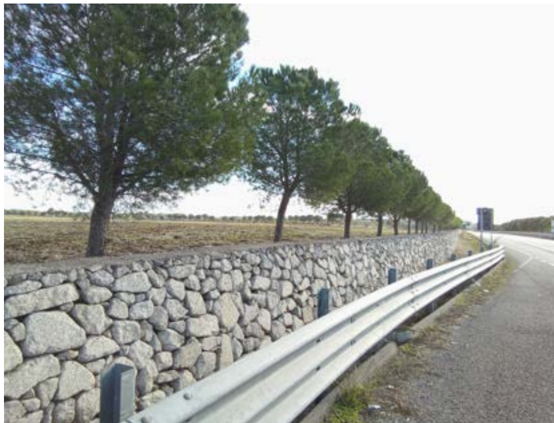
Infrastruttura stradale interessata dalle lavorazioni
