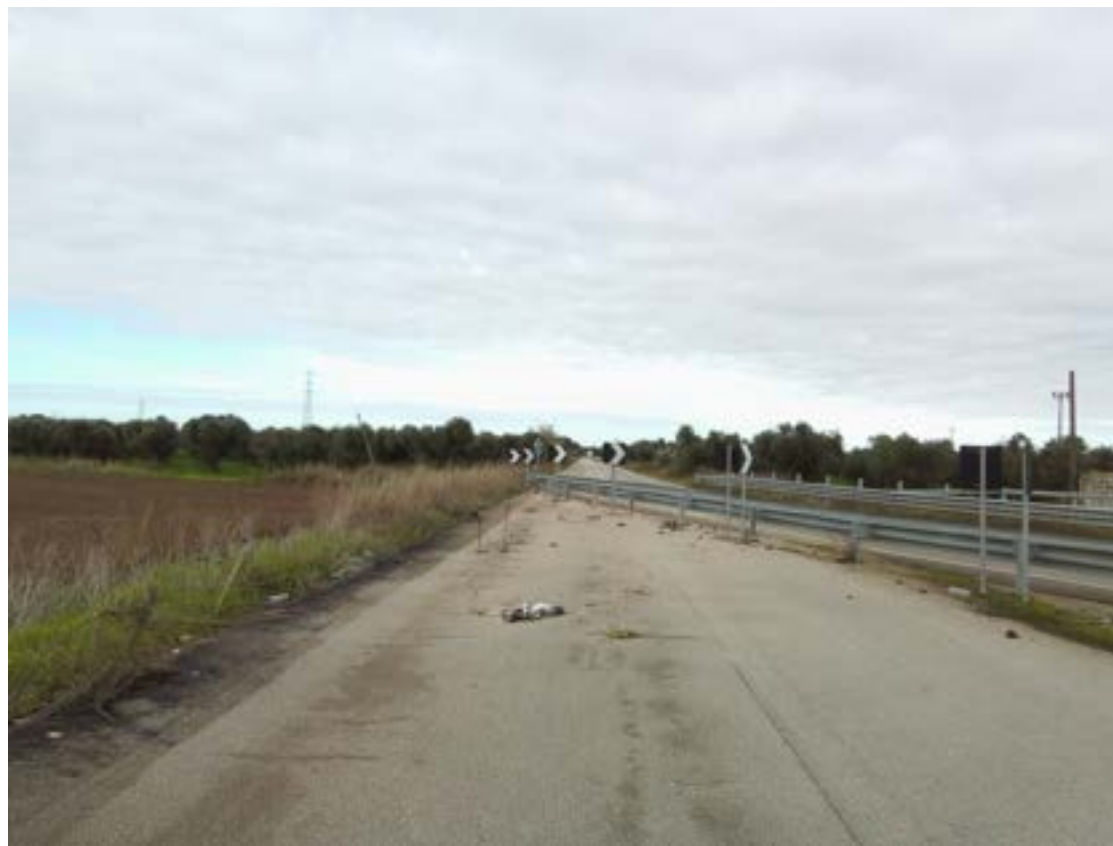
Infrastruttura stradale dismessa interessata dalle lavorazioni
