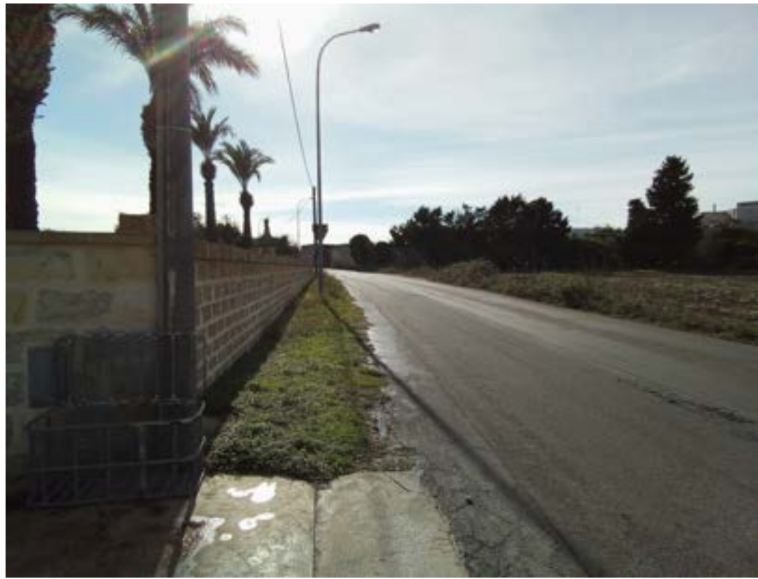
Area infrastrutturata a lato del percorso dell'elettrodotto
