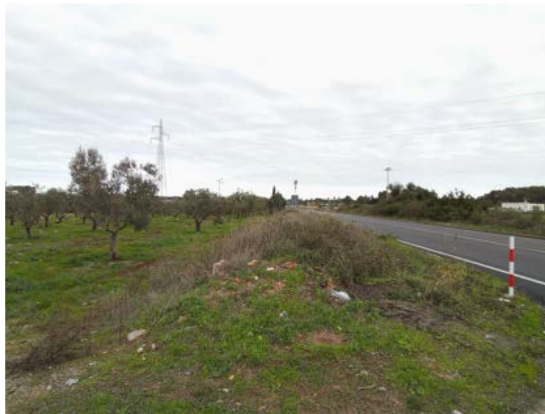
Tratto stradale interessato dalle lavorazioni
