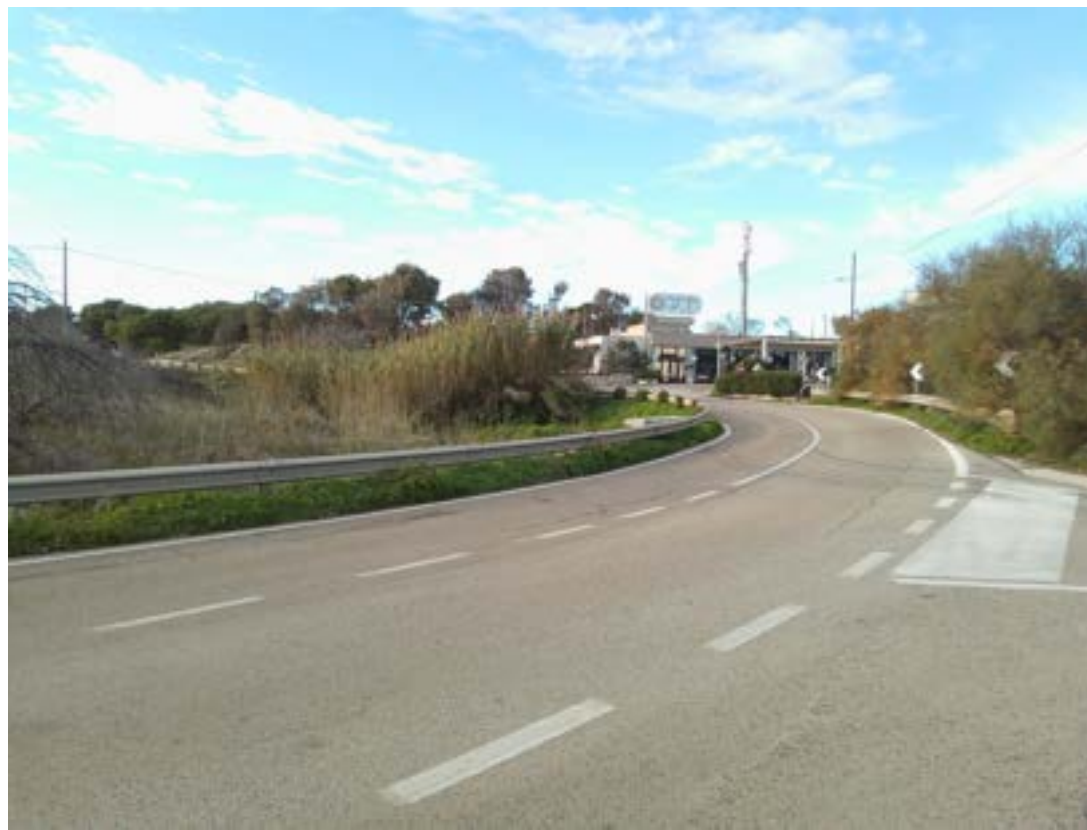
Area ai lati del tratto iniziale dell'elettrodotto
