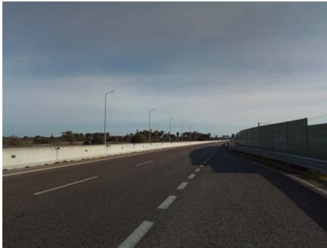
Asse stradale interessato dalle lavorazioni
