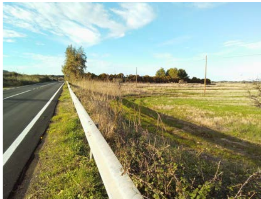
Area ai lati del tratto iniziale dell'elettrodotto
