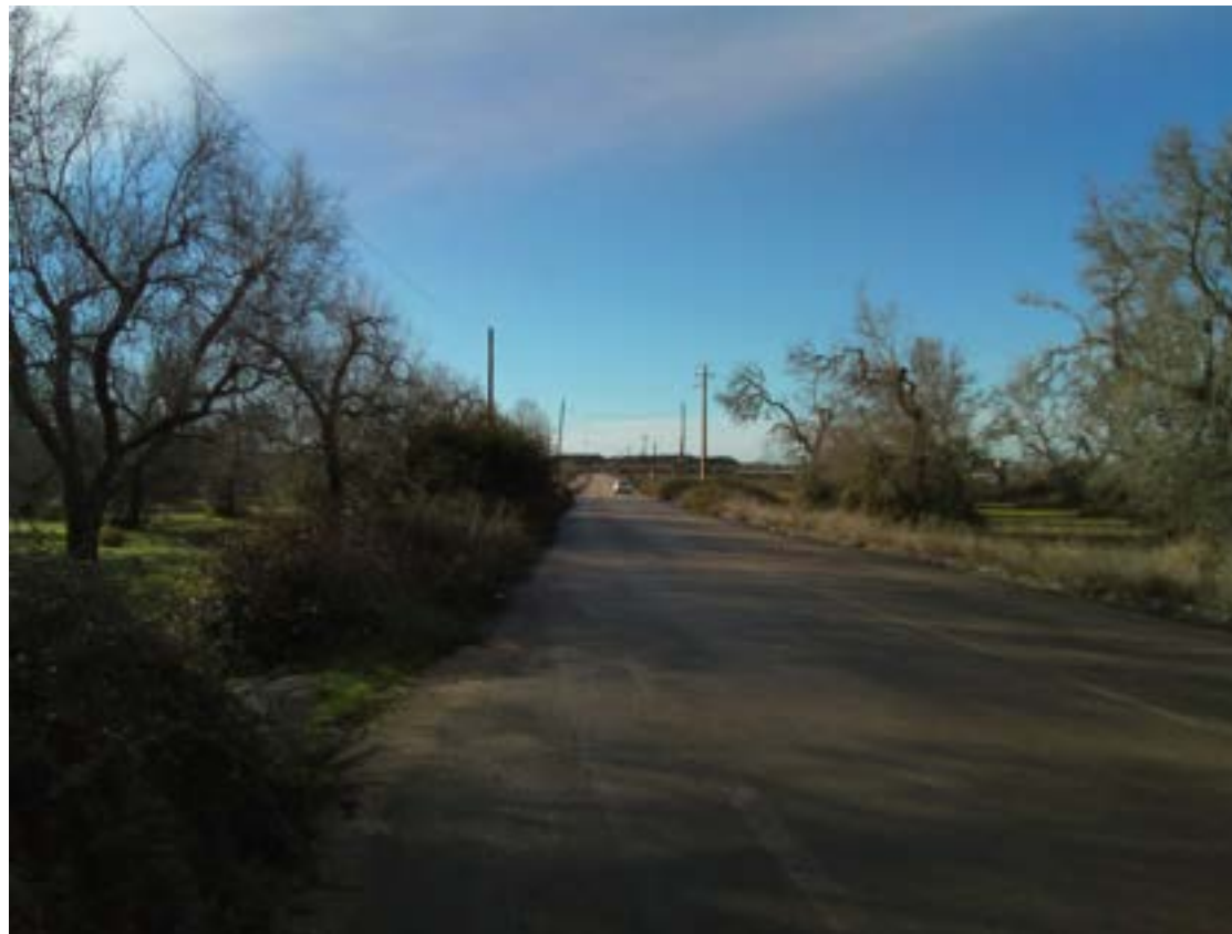
Asse stradale interessato dalle lavorazioni
