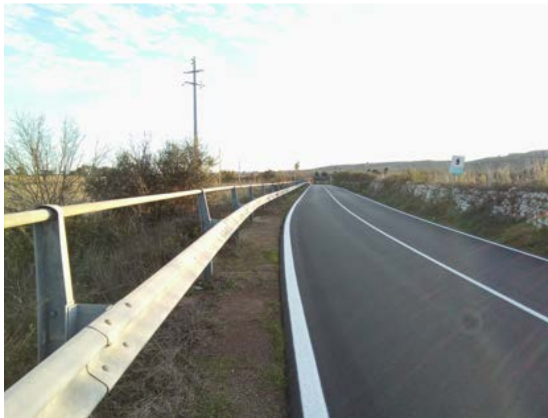
Area ai lati del tratto iniziale dell'elettrodotto
