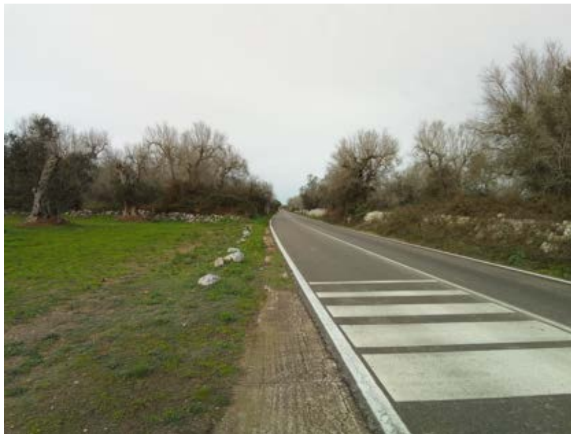
Asse stradale interessato dalle lavorazioni
