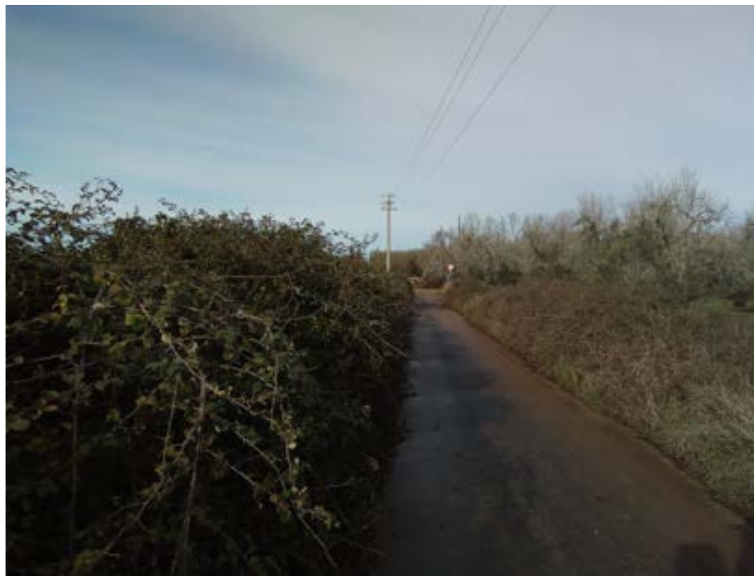
Strada in area campestre interessata dalle lavorazioni
