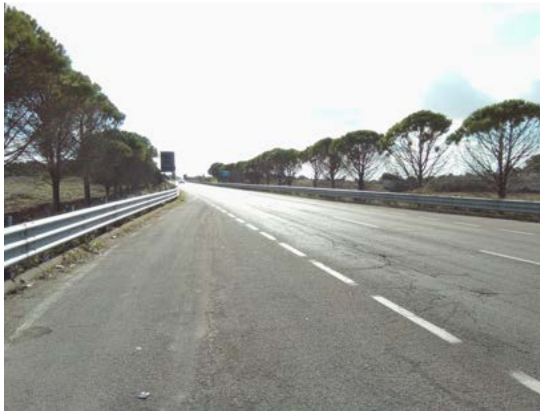
Infrastruttura stradale interessata dalle lavorazioni
