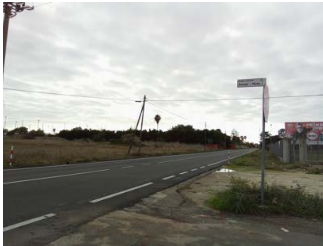
Tratto stradale interessato dalle lavorazioni
