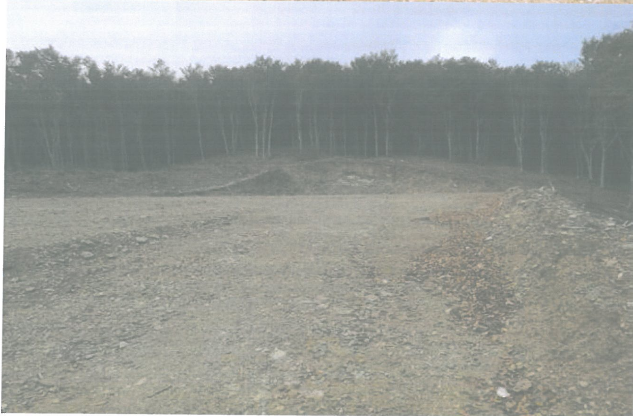
Sbancamenti effettuati sull'area di installazione dell'impianto Pràboe realizzato a partire dal 2022
