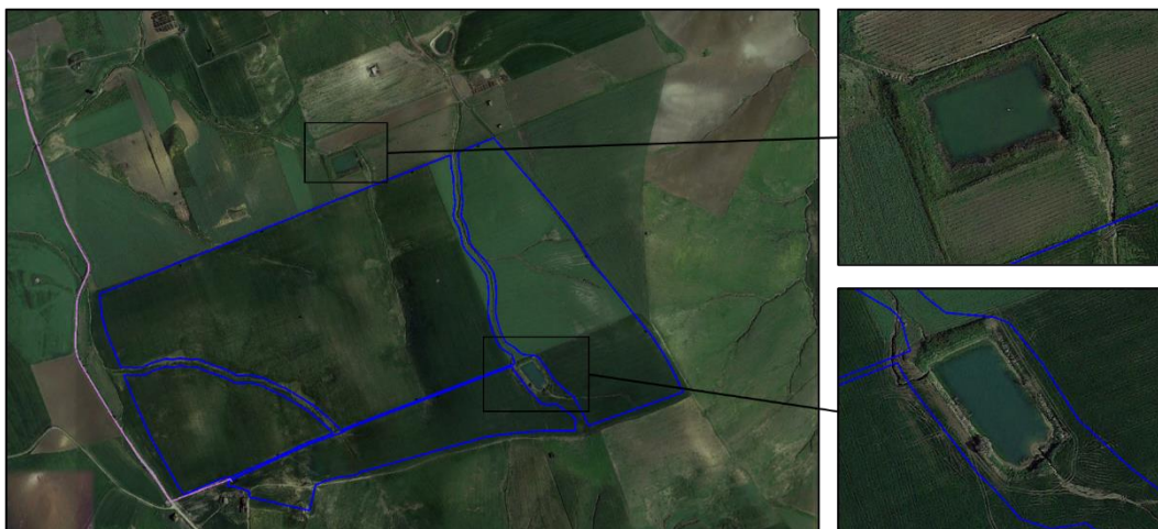
Figura 2.10: Dettaglio delle vasche di raccolta delle acque da Google Earth.
