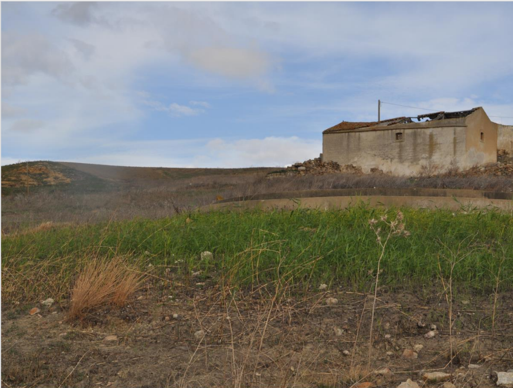
Figura 33. Vista da punto 16 "Masseria sud verso Nord".
