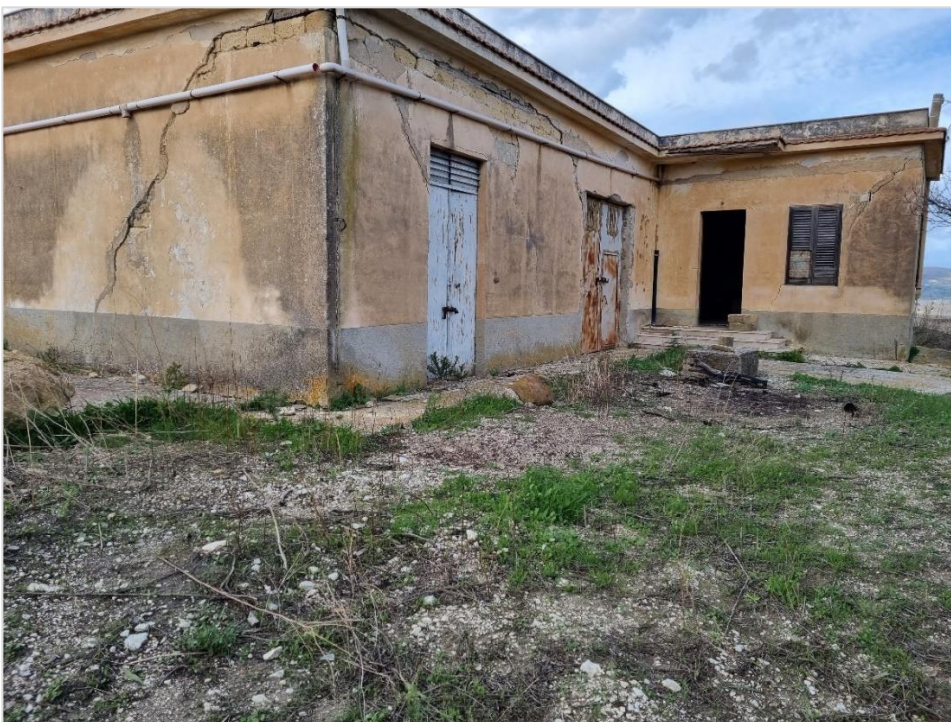
Figura 10. Rudere a nord dell'impianto.
