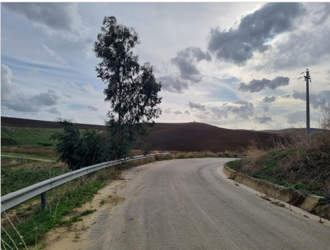
Figura 26. Vista da punto 9 "SP46 verso Sud-Ovest".
