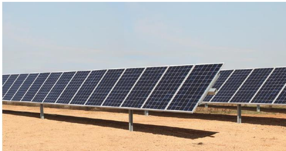
Figura 6.3. – Esempio di inseguitori monoassiali.
