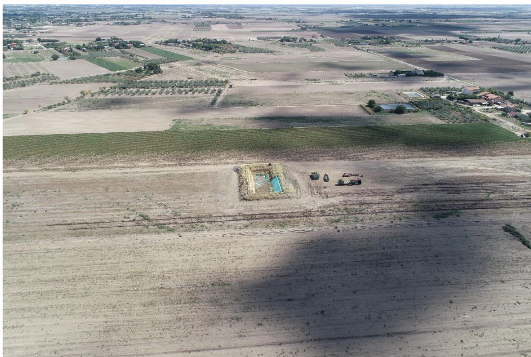
Foto 3 – Immagine ripresa da drone: visuale direzione Nord-Est.
