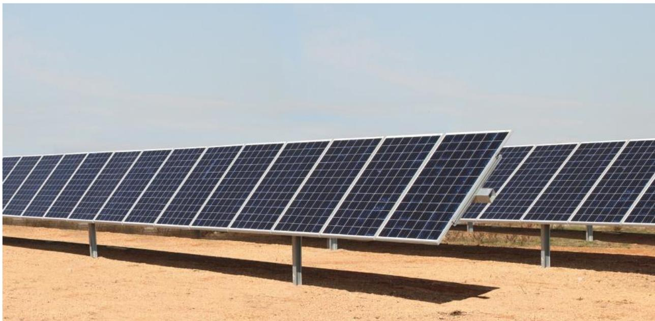
L'utilizzo di tali strutture permette di orientare i moduli fotovoltaici favorevolmente rispetto ai raggi solari nel corso della giornata, mantenendo invariata l'inclinazione dell'asse di rotazione del pannello rispetto al terreno, ovvero mantenendo invariato l'angolo di TILT.
