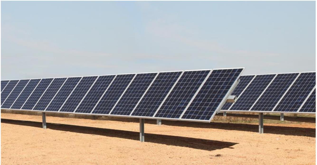
Il tracker monoassiale è di tipo orizzontale ad asse singolo ed utilizza dispositivi elettromeccanici per inseguire il sole durante tutto il giorno da est a ovest sull'asse di rotazione orizzontale nord-sud (inclinazione 0°).
