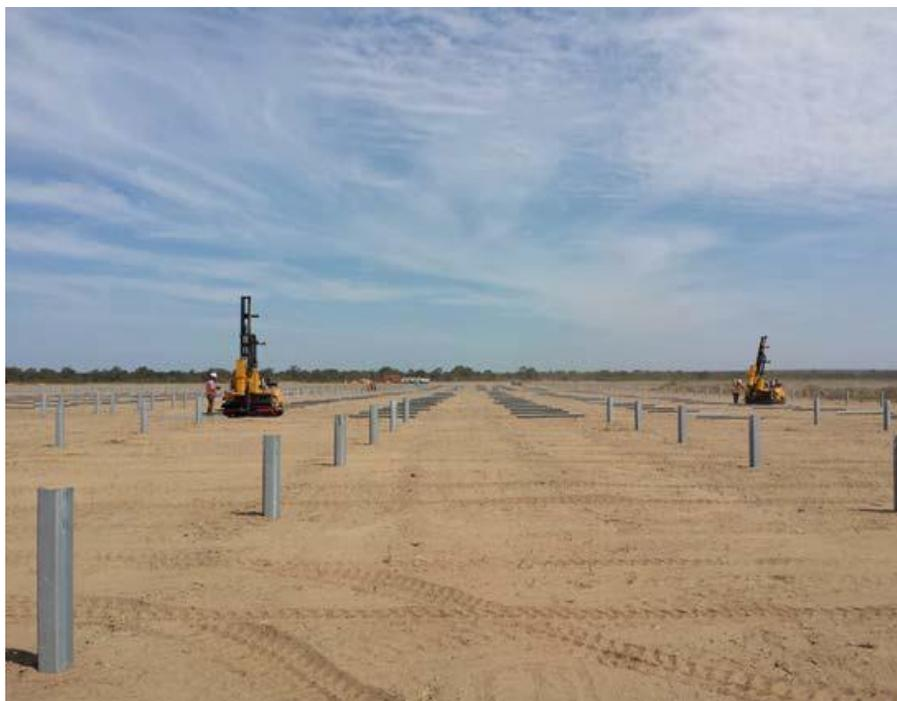
L'infissione dei profili di palificazione nel terreno viene eseguito con battipali idraulici con riguardo al terreno. Questo procedimento di palificazione è particolarmente indicato soprattutto in caso di impianti di grandi dimensioni; con una macchina si può realizzare, a seconda del terreno, una potenza di circa 250 pali al giorno.
