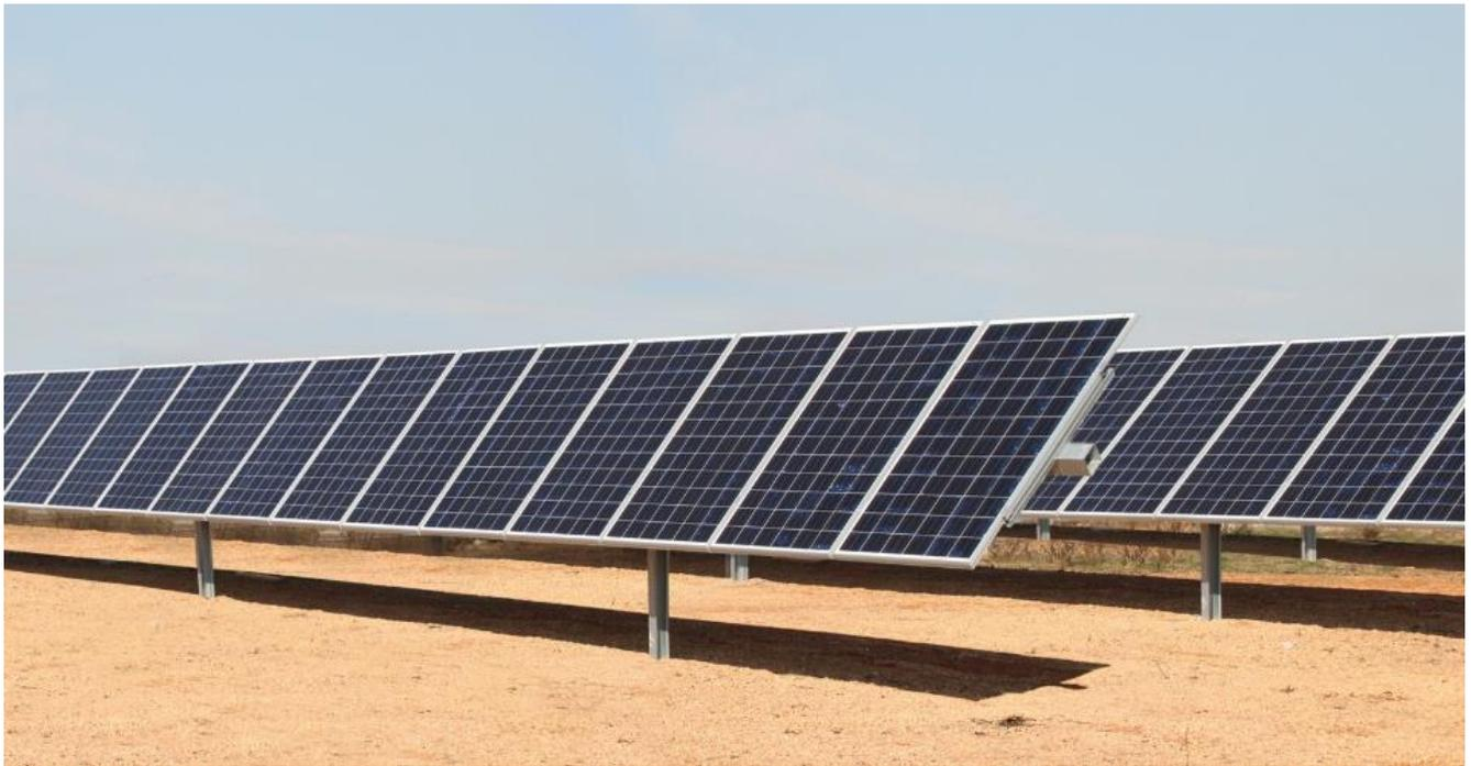
L'utilizzo di tali strutture permette di orientare i moduli fotovoltaici favorevolmente rispetto ai raggi solari nel corso della giornata, mantenendo invariata l'inclinazione dell'asse di rotazione del pannello rispetto al terreno, ovvero mantenendo invariato l'angolo di TILT.
