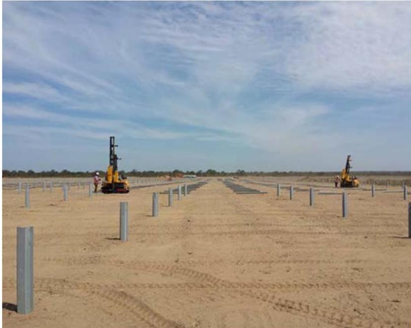
L'infissione dei profili di palificazione nel terreno con battipali idraulici è particolarmente indicata soprattutto in caso di impianti di grandi dimensioni; con una macchina si può realizzare, a seconda del terreno, una potenza di circa 250 pali al giorno. Sono possibili anche forme di terreno più difficili (pietre ecc.); in caso di sottosuoli in roccia, la macchina può essere attrezzata aggiuntivamente con un gruppo di foratura. Il montaggio è possibile anche su pendii.
