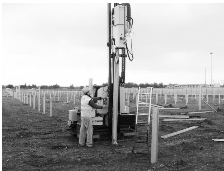
Figura 17 – Infissione con macchina battipalo
