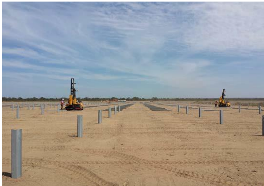
Figura 16 – Posa in opera profili di palificazione
