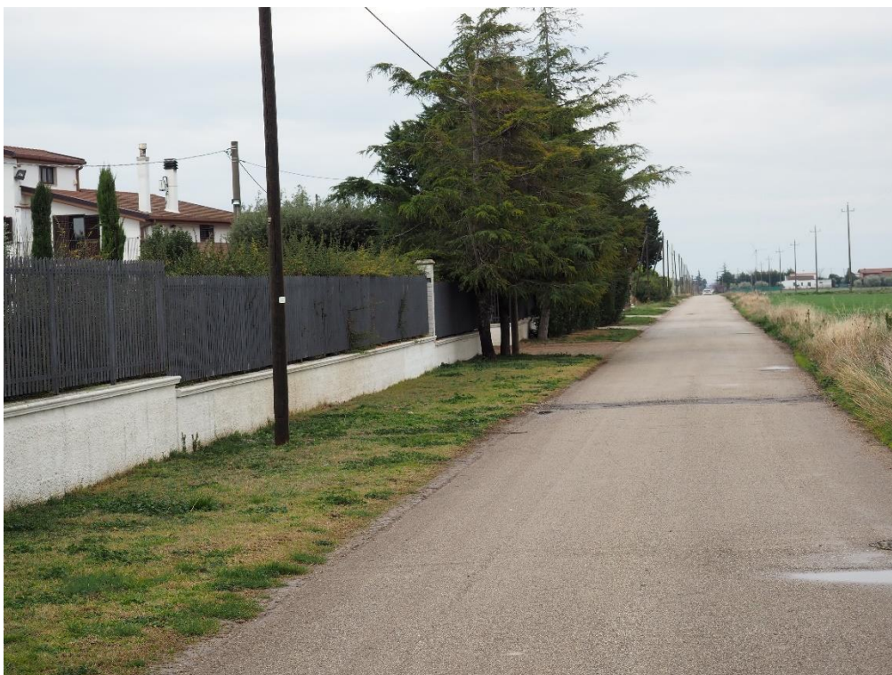
Punto di ripresa_3 – Visuale sud sud-est
