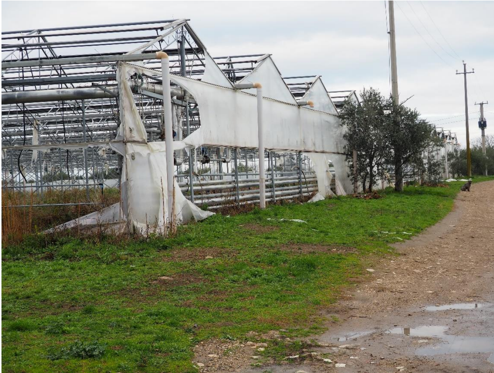
Punto di ripresa_7a – Visuale nord ovest
