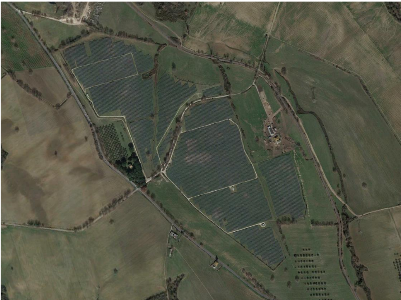
Figura 20 - Veduta impianto esistente
