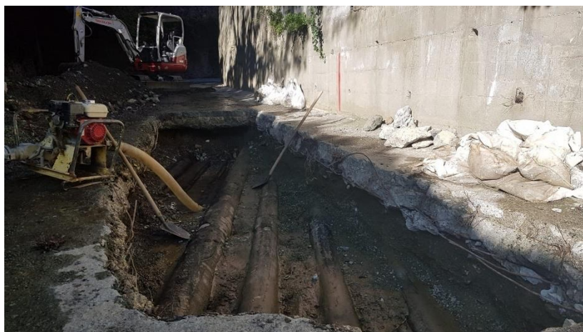
Figura 22 - Immagine dello scavo effettuato da SIGEMI all'interno dell'attuale rio Molinassi in corrispondenza della futura briglia a fune
