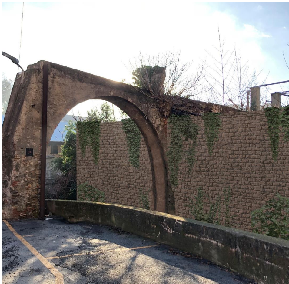
Figura 27: Foto-inserimento del nuovo muro di sponda nel giardino di pertinenza della Villa Spinola Pallavicino
