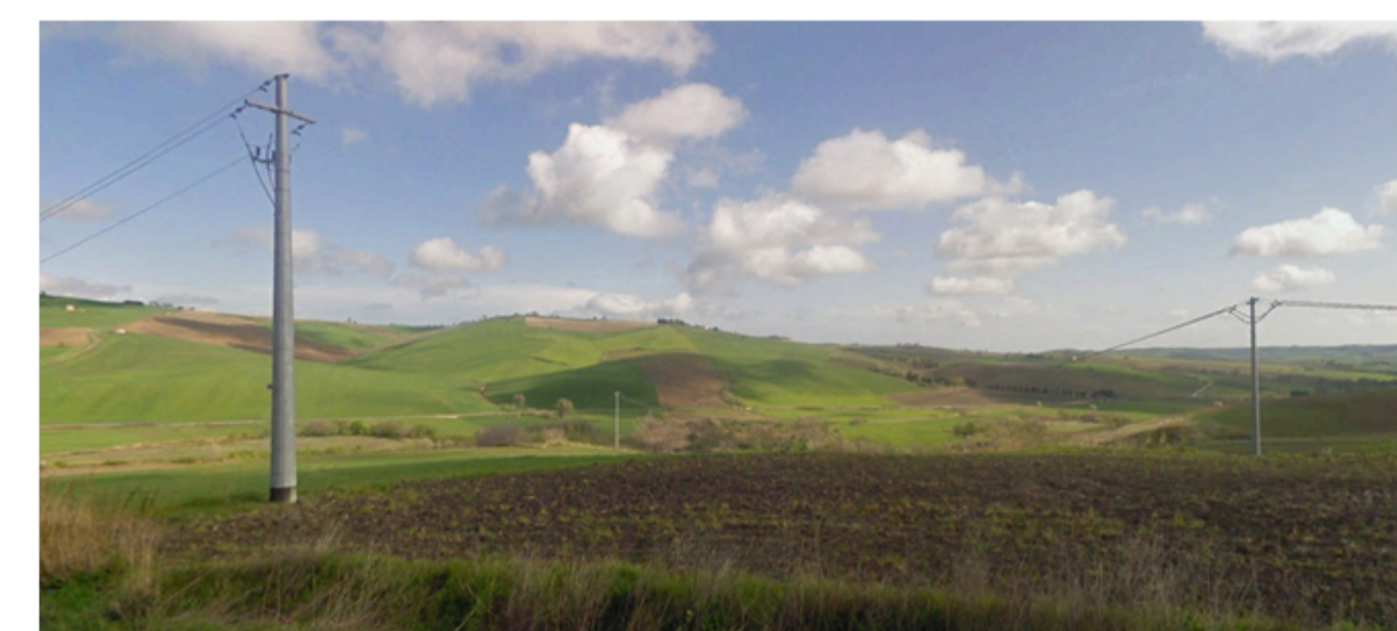
Ripresa fotografica dal punto ripresa 8
