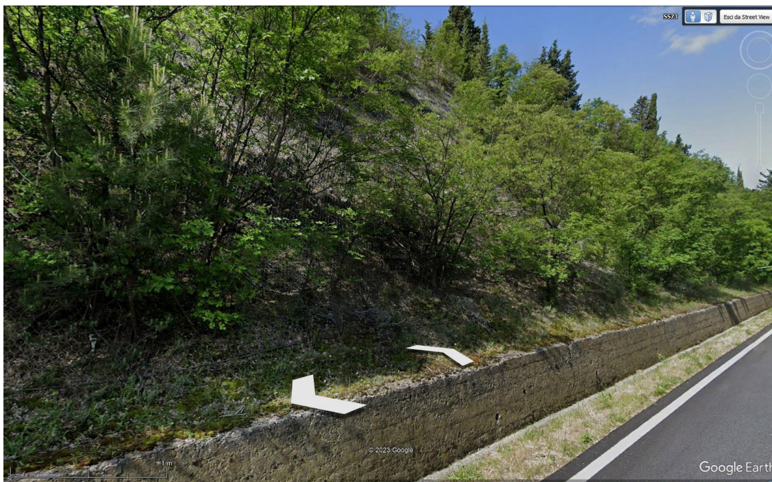
Figura 7-53 Opere esistenti tra le prog. 2+675 a prog. 2+875
