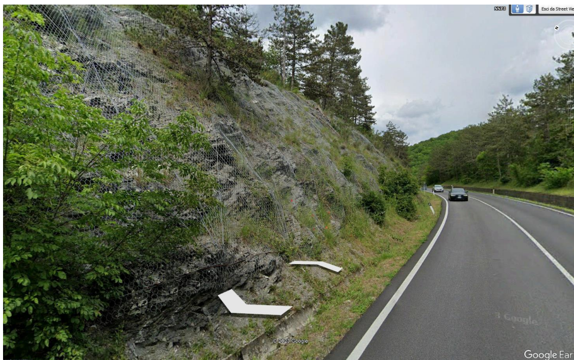
Figura 7-58 Opere esistenti tra le prog. 5+875 a prog. 6+025
