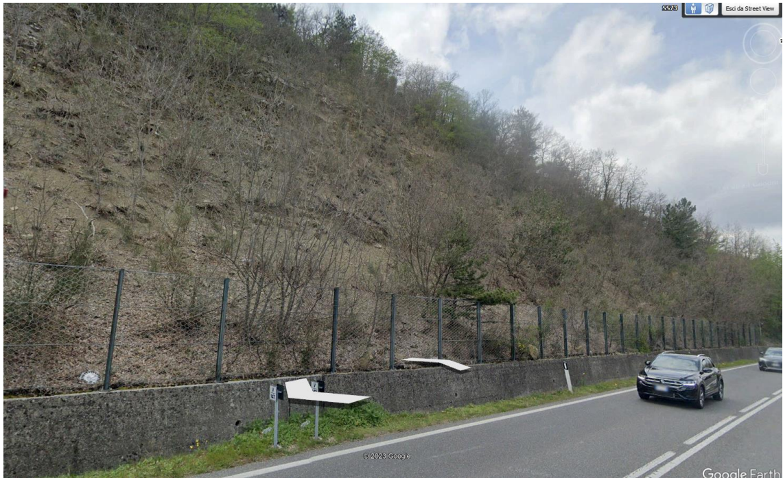
Figura 7-54 Opere esistenti tra le prog. 4+850 a prog. 4+975
