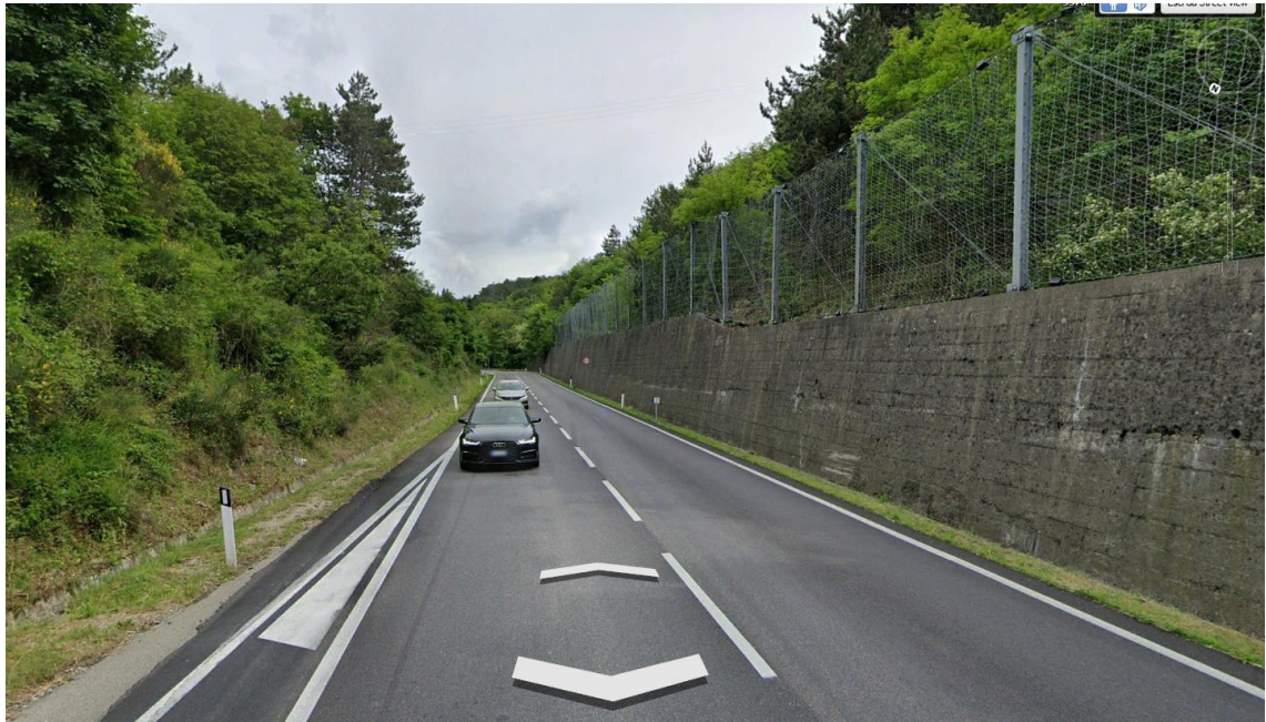
Figura 7-56 Opere esistenti tra le prog. 5+200 a prog. 5+300
