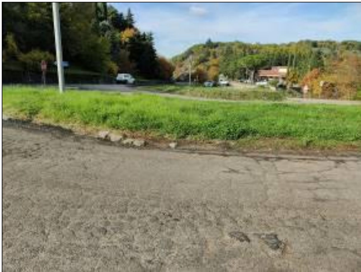
Figura 9-1 Panoramica della zona di nicchia coincidente con lo svincolo di Stoppe d'Arca
