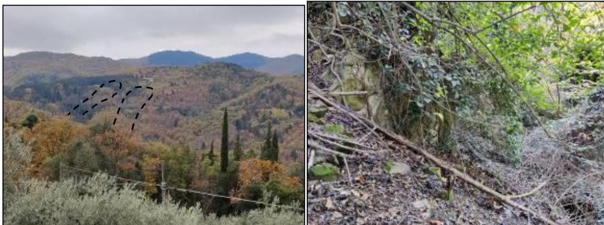
Figura 15-2 Foto 1: foto panoramica della zona di nicchia; Foto 2: è stata riportata l'estensione del dissesto sull'intero pendio, ripreso dal versante opposto.
