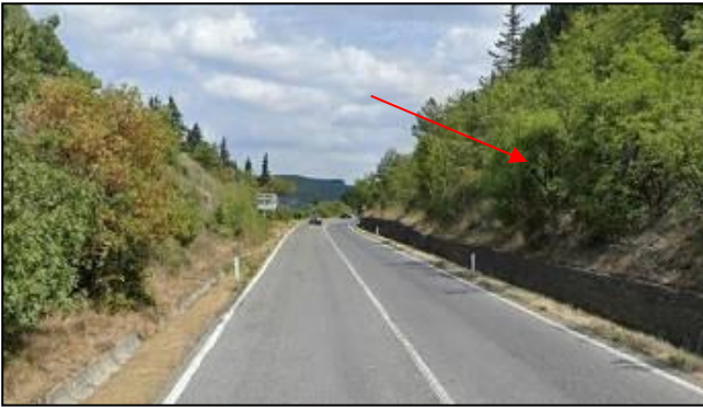
Figura 8-2 Vista della SS 73 direzione Fano. Nella foto di sinistra panoramica della scarpata interessata dal dissesto. Nella foto di destra visibili le Arenarie di Cervarola con stratificazione a franapoggio con rete metallica, funi e chiodi; visibile in basso l'accumulo di cunei litoidi franati.
