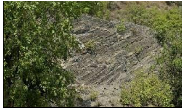
Figura 8-2 Vista della SS 73 direzione Fano. Nella foto di sinistra panoramica della scarpata interessata dal dissesto. Nella foto di destra visibili le Arenarie di Cervarola con stratificazione a franapoggio con rete metallica, funi e chiodi; visibile in basso l'accumulo di cunei litoidi franati.
