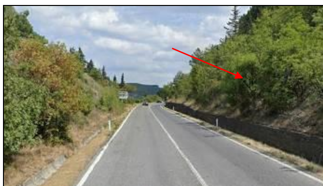
Figura 7-11 Vista della SS 73 direzione Fano – Nella foto di sinistra panoramica della scarpata interessata dal dissesto. Nella foto di destra visibili le Arenarie di Cervarola con stratificazione a franapoggio consolidate con rete metallica, funi e chiodi; visibile in basso l'accumulo di cunei litoidi franati
