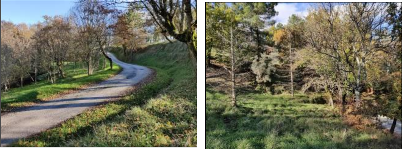
Figura 7-48 In sinistra foto panoramica del corpo di frana su cui si sviluppa una strada vicinale; in destra panoramica del fianco sinistro del dissesto.
