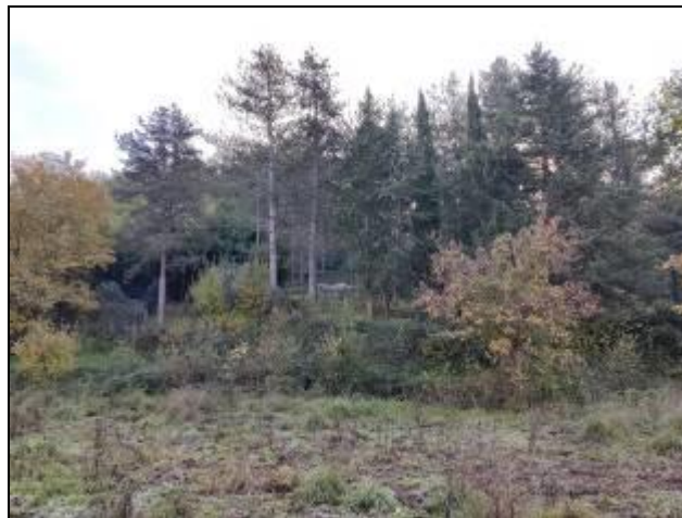
Figura 7-1 Vista di insieme del settore di coronamento Frana 1
