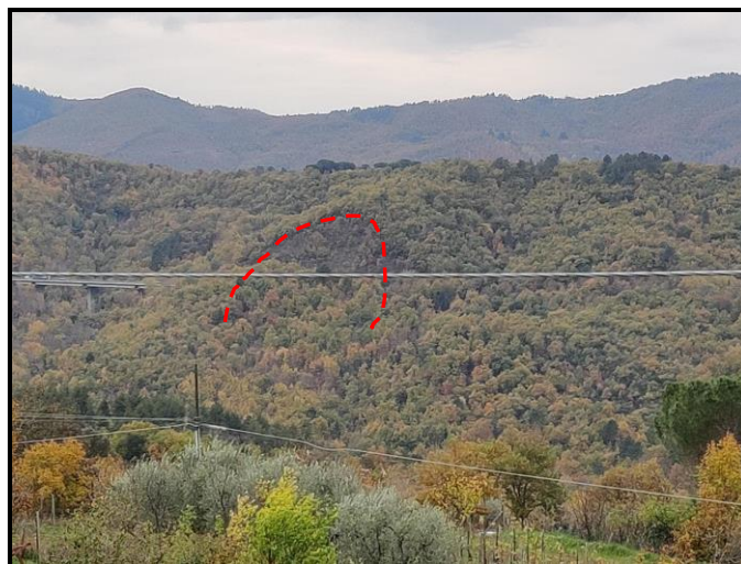
Figura 7-52 Estensione del dissesto ripreso dal versante opposto.
