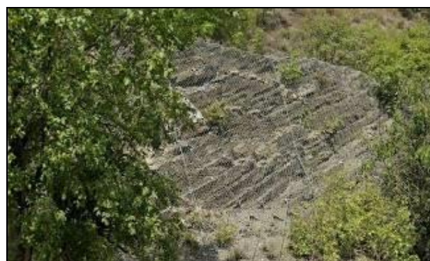
Figura 7-11 Vista della SS 73 direzione Fano – Nella foto di sinistra panoramica della scarpata interessata dal dissesto. Nella foto di destra visibili le Arenarie di Cervarola con stratificazione a franapoggio consolidate con rete metallica, funi e chiodi; visibile in basso l'accumulo di cunei litoidi franati
