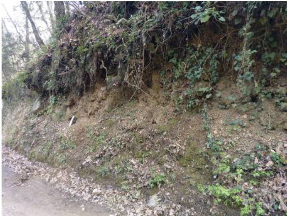
Stazione geomeccanica SG7
