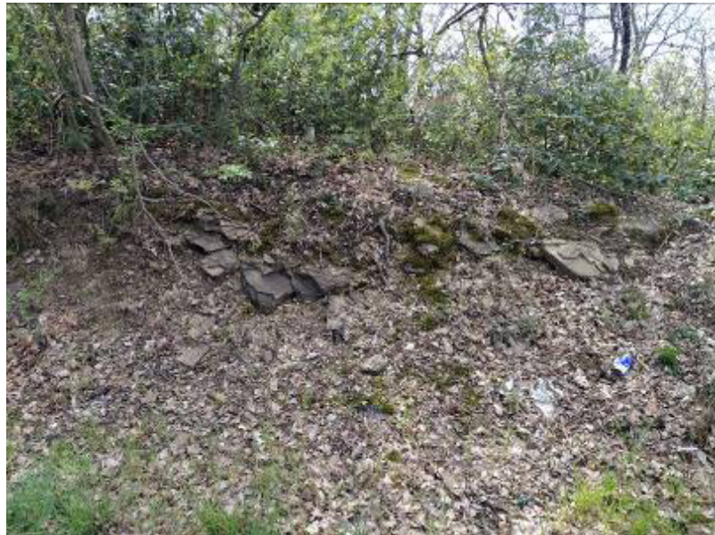
Stazione geomeccanica SG4
