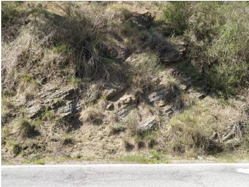
Stazione geomeccanica SG10
