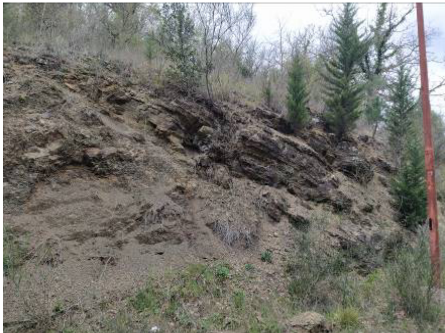
Stazione geomeccanica SG5
