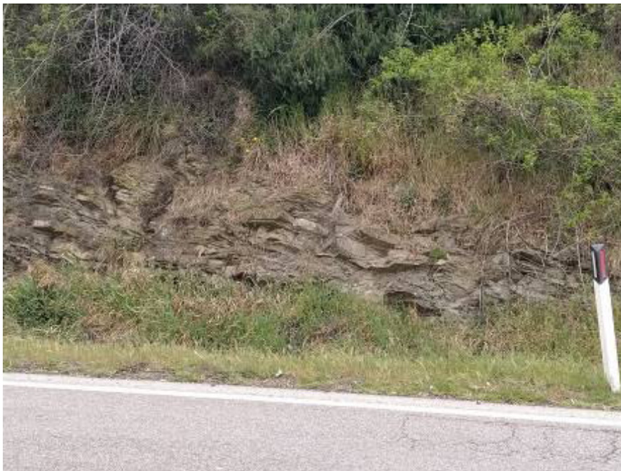
Stazione geomeccanica SG1
