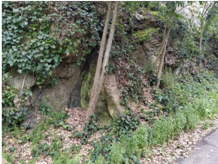
Stazione geomeccanica SG2
