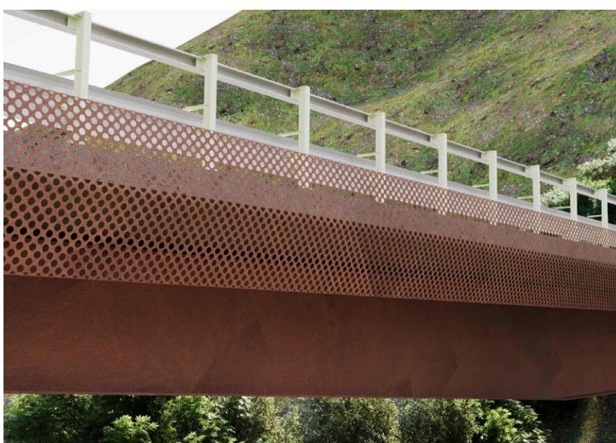
Figura 9.10 Immagine tipologica dei carter di rivestimento
