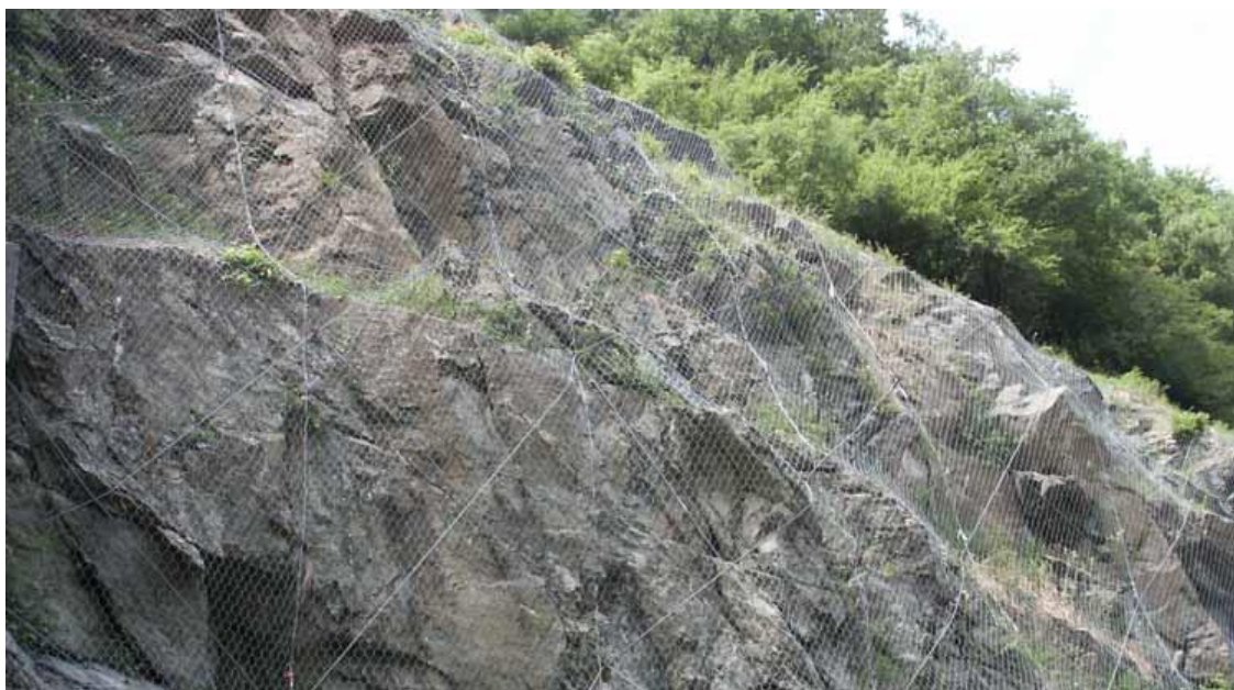
Figura 9.22 Esempio di versante con rete paramassi
