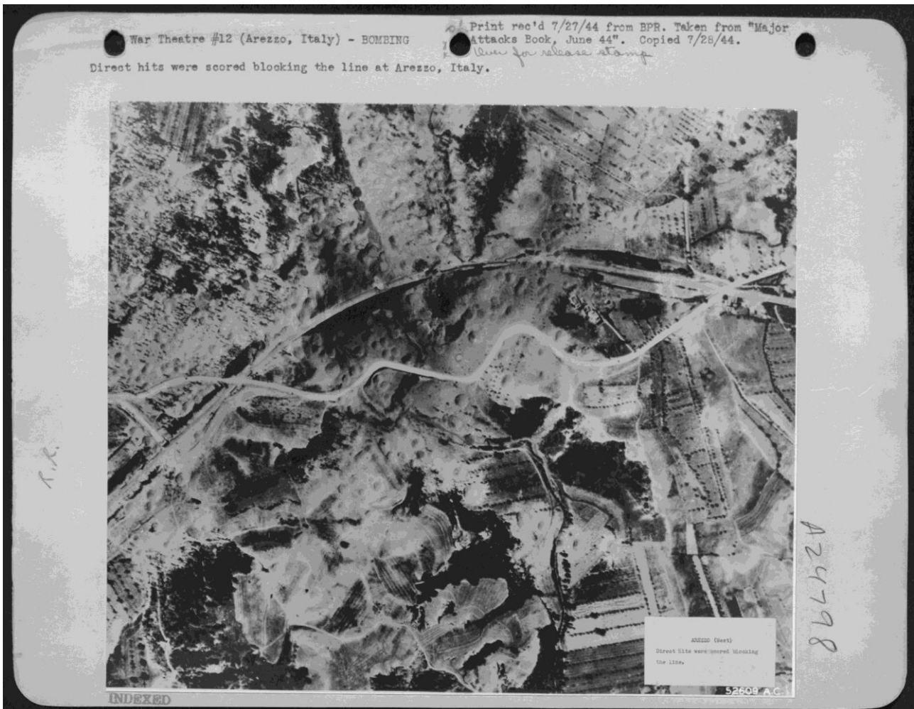
Figura 8.3 – Colpi diretti per bloccare la linea ferroviaria di Arezzo
