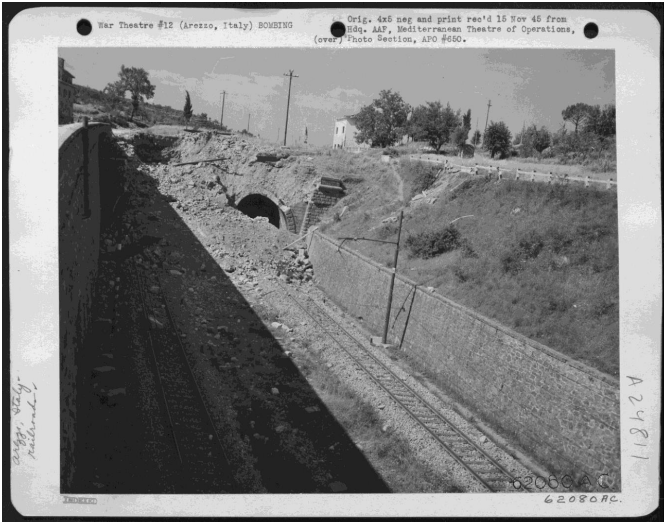
Figura 8.6 – Bombardamento sottopasso ferroviario
