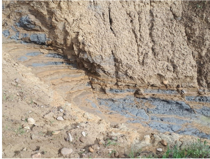
Figura 14 – Formazione argillosa stratificata messa a nudo dall'erosione lineare
