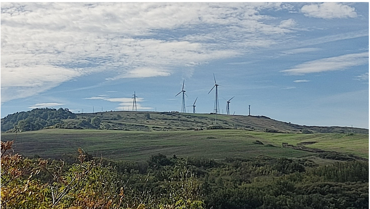
Punto di presa n° 2 - Stato di Fatto
