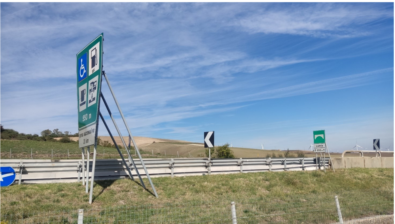
Punto di presa n° 22 - Stato di Fatto
