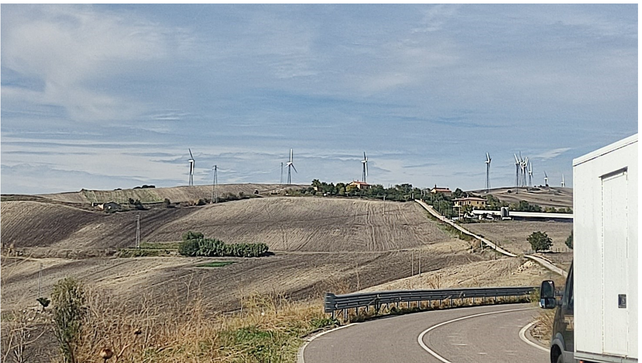
Punto di presa n° 28 - Stato di Fatto
